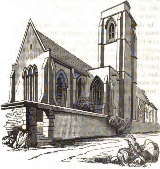
VUE DE L'ÉGLISE DE DEMOUVILLE (côté du nord).
