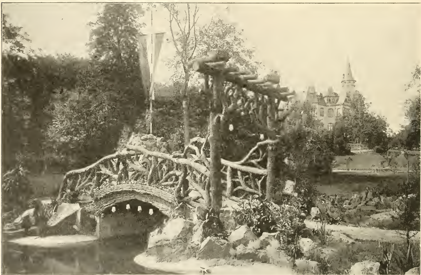
Abbildung 6. Rustike Brücke im Park des Herrn Fabrikbesitzer Wernicke in Halle a. S., erbaut von C. Voigt in Eisleben a. Harz.
