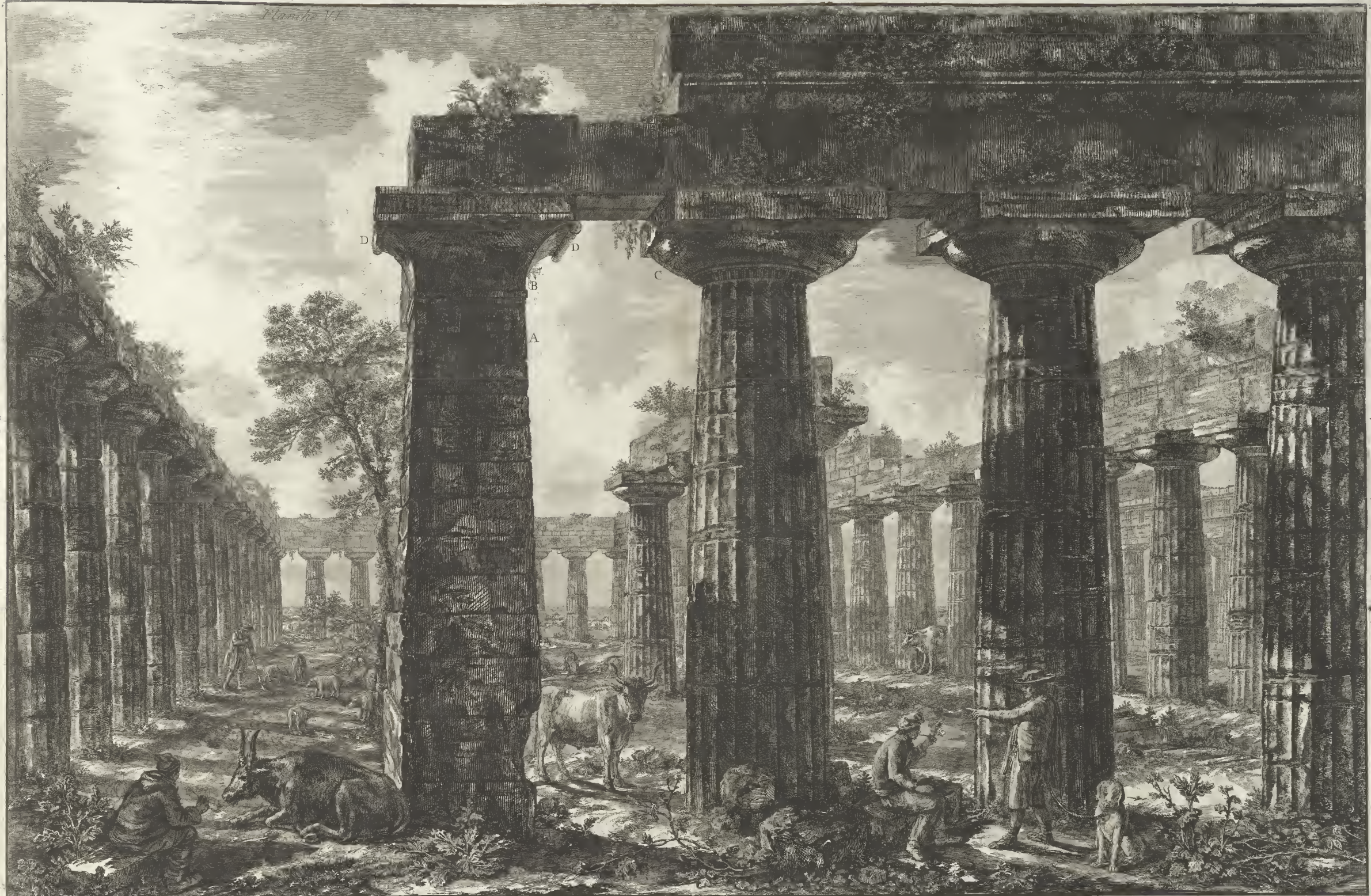
Autre Vüe de la Fassade du Pronaos, dessinée et décrite dans la planche V. Les Pilastres A ont l'entabl. ou le 1 er fût. Les Chapiteaux B sont d'une forme différente de ceux des Colonnades C, ils sont d'une architecture qui paroit grotesque, et ils semblent plutôt qui par eux mêmes se caractérisent pour Ioniques que pour Doriques.
