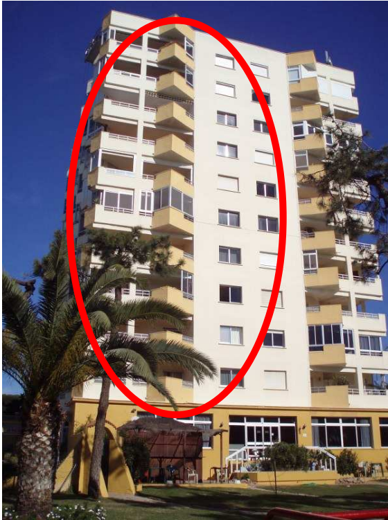
1 - Vista Fachada Sur
