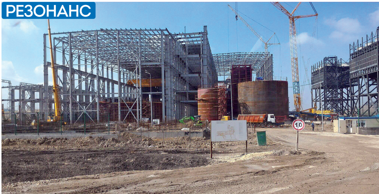
Будівництво Сімферопольської ТЕС у с. Строгонівка
