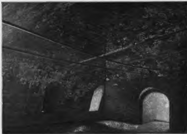
Рис. 330. 1-я Безымянная башня. Внутренность 2-го этажа.
