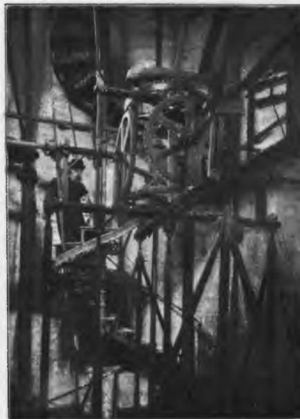
Рис. 140. Механизмъ, водящій часовыя стрѣлки, въ 8-мъ этажѣ Спасской башни.
