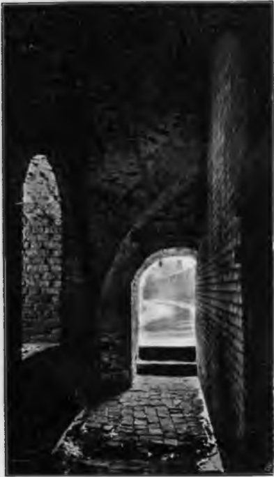
Рис. 352. Петровская башня. Проходъ внутри башни съ одного прясла на другое.
