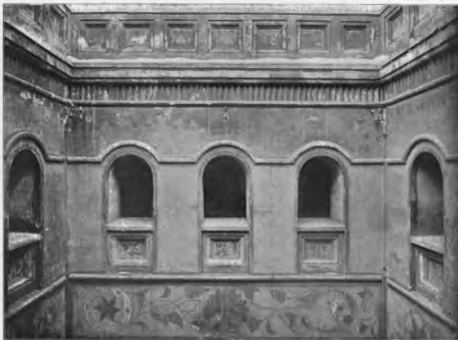
Рис. 148. Спасская башня. Внутреннія окна отводной стрѣльницы надъ проѣздомъ.
