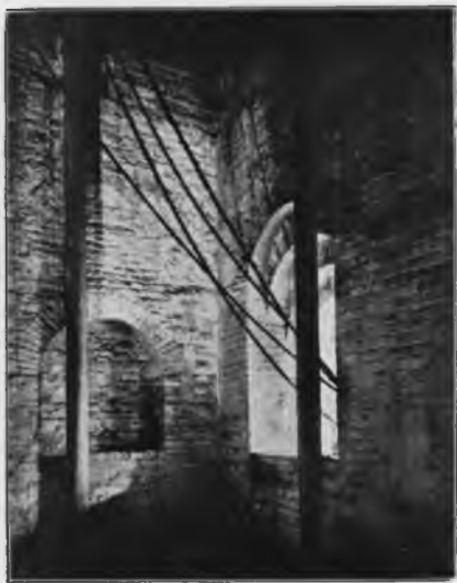
Рис. 131. Слѣды заложенныхъ пролетовъ и готическихъ оконъ въ 6-мъ этажѣ Спасской башни.
