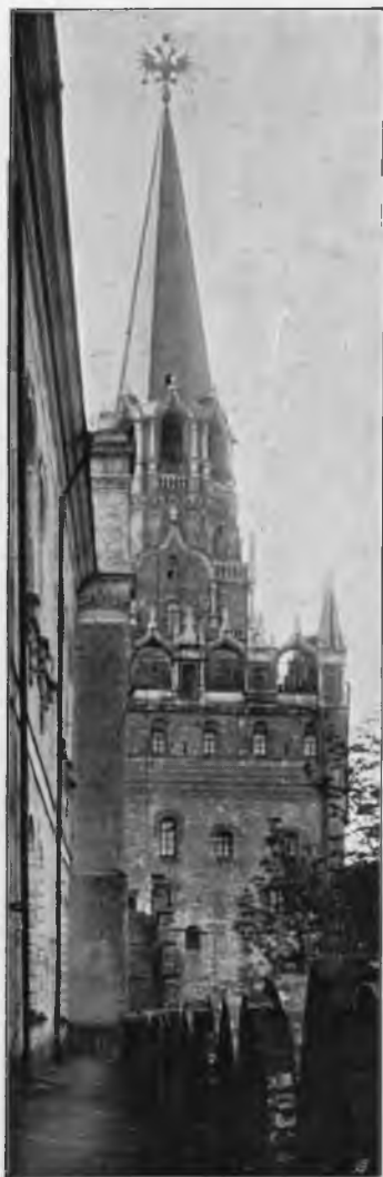
Рис. 101. Дымоходъ электрической станціи близъ Троицкой башни.
