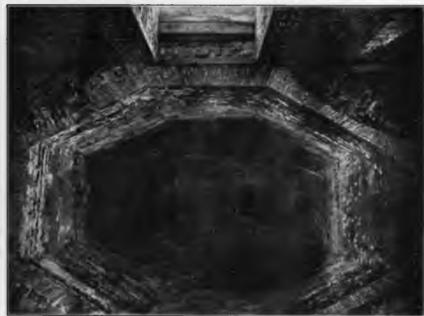
Рис. 354. Петровская башня. Сводъ верха.
