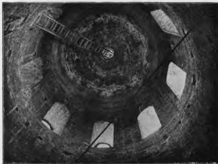
Рис. 258. Водовзводная башня. Сводь второго этажа.
