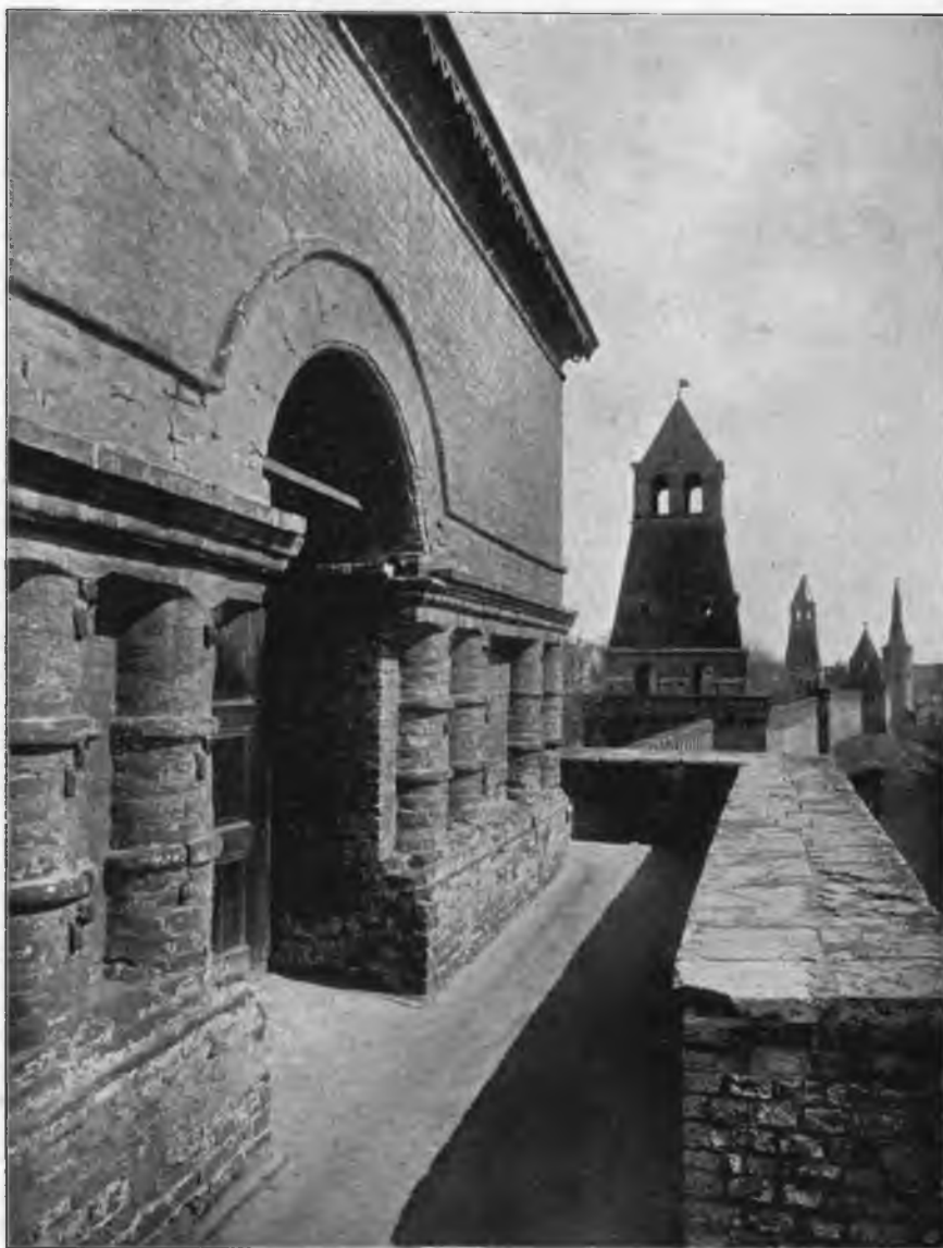
Рис. 225. Тайницкая башня. Архитектурная обработка основанія верха.
