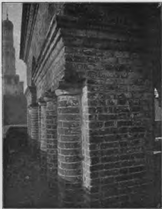
Рис. 331. 2-я Безымянная башня. Обработка дверныхъ пролетовъ верха.
