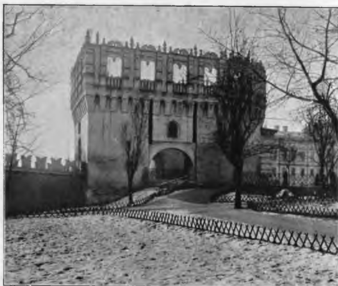
Рис. 183. Кутафья, боковой фасадъ. Надъ проходомъ видны щели для механизма подъемнаго моста.
