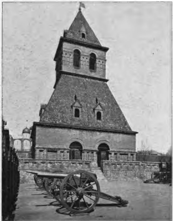
Рис. 224. Тайницкая башня. Платформа отводной башни и фасадъ верха со стороны Москвы рѣки.
