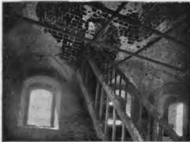
Рис. 219. Боровицкая башня. 7 этажъ.
