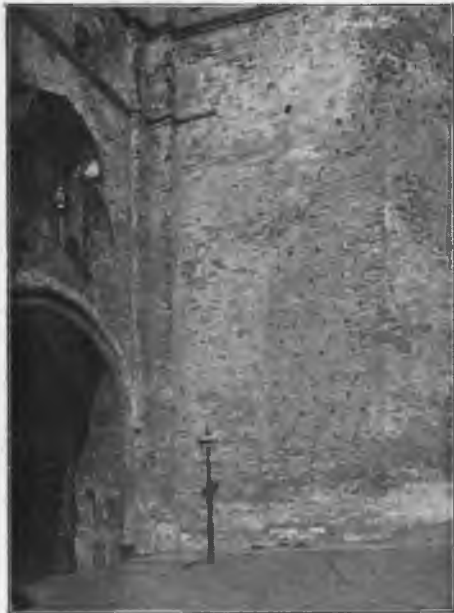
Рис. 99. Слѣды заложеной арки на загибѣ стѣны, рядомъ съ отводной башней Боровицкихъ воротъ (со стороны Кремля).
