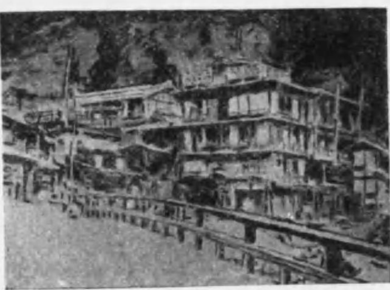
源泉の館の外観
