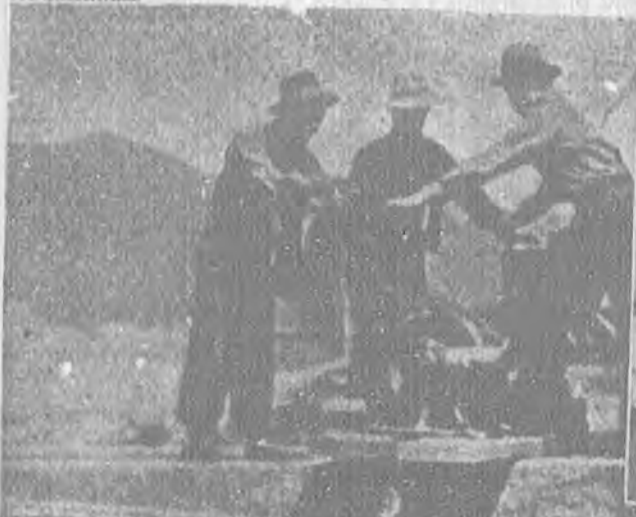
錢塘江鐵橋自興工以來，工程進行極速，此為江心建築橋墩之情形
