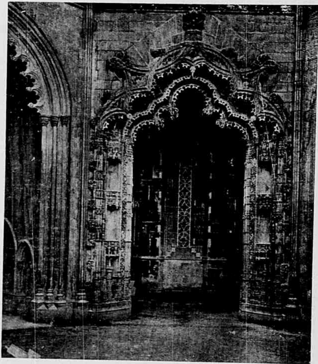
PORTA DAS CAPELLAS IMPERFEITAS — BATALHA
