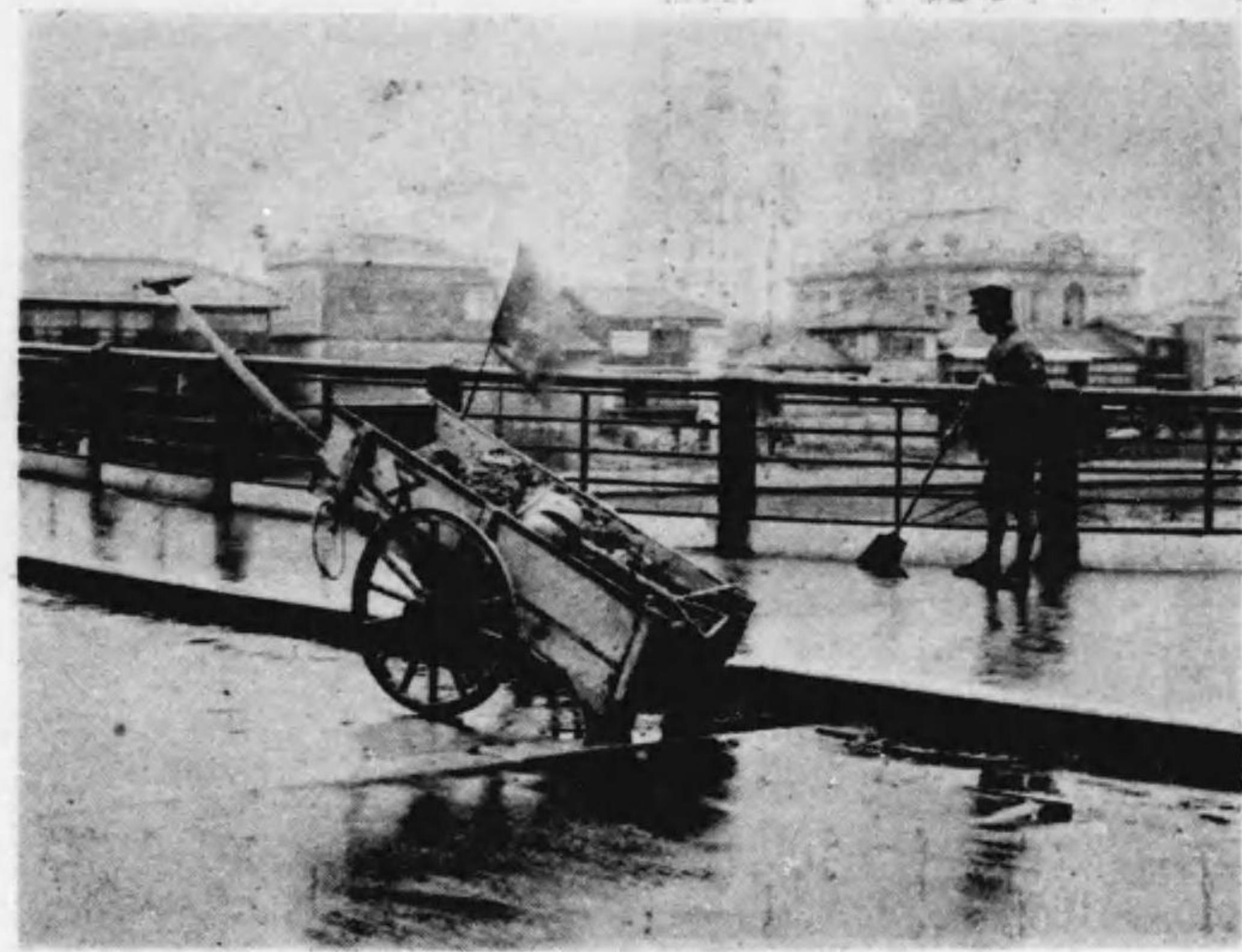
橋面掃除作業
