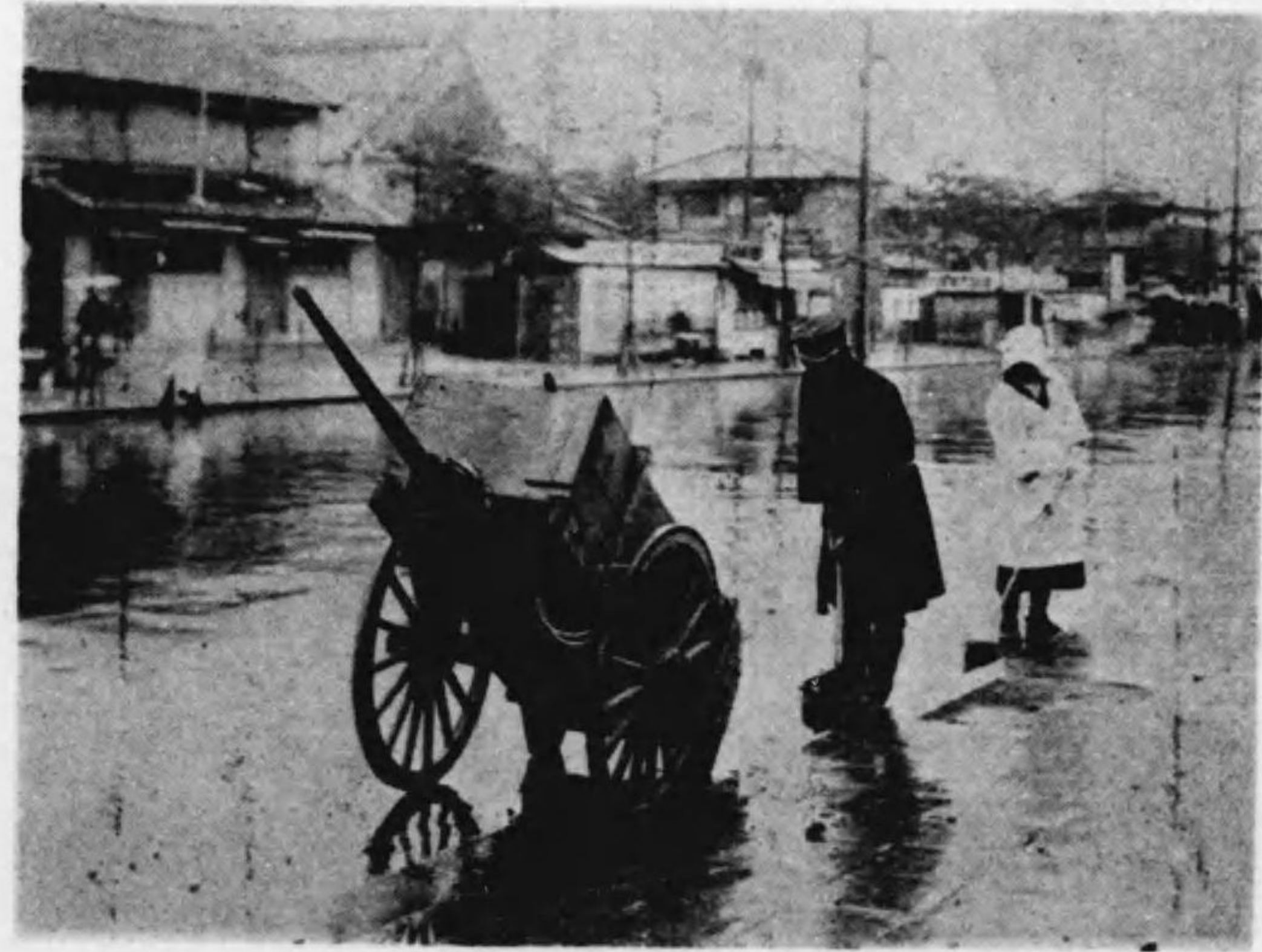
側溝掃除作業
