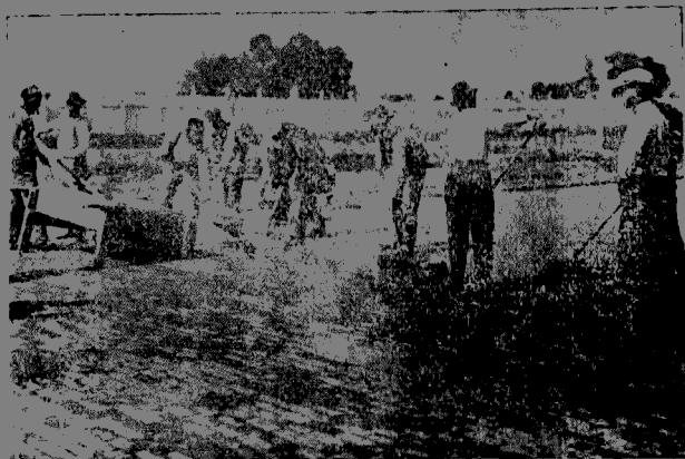
第五十圖 用水泥膠沙漿灌入磚路之縫
