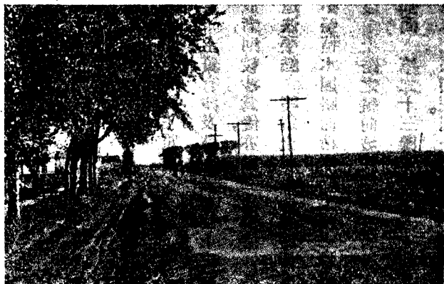
第二十二圖 築造及保養俱合法之土路
