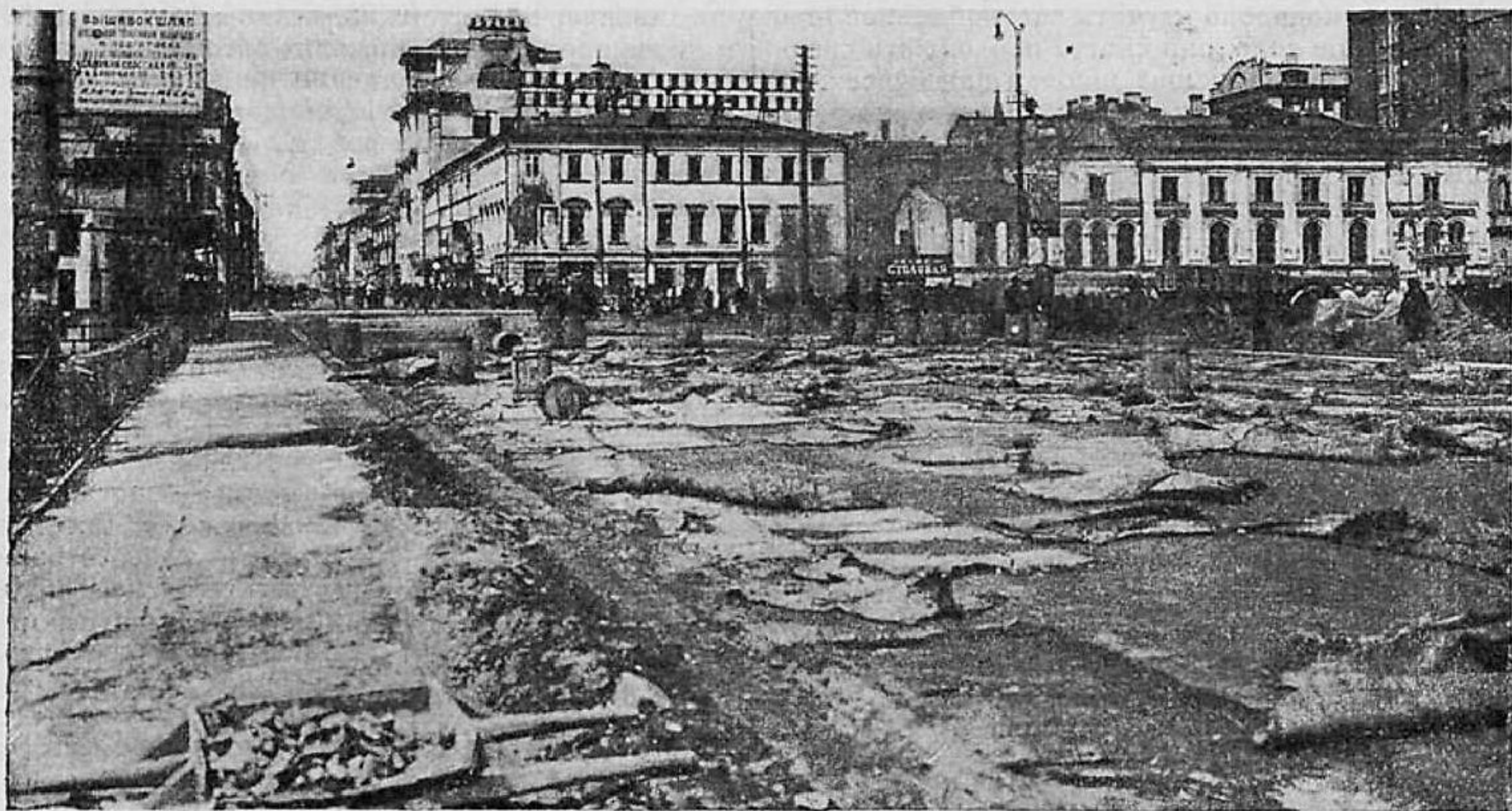
Мостовые Москвы. Устройство бетонного основания под литой асфальт (Страстная площадь)
