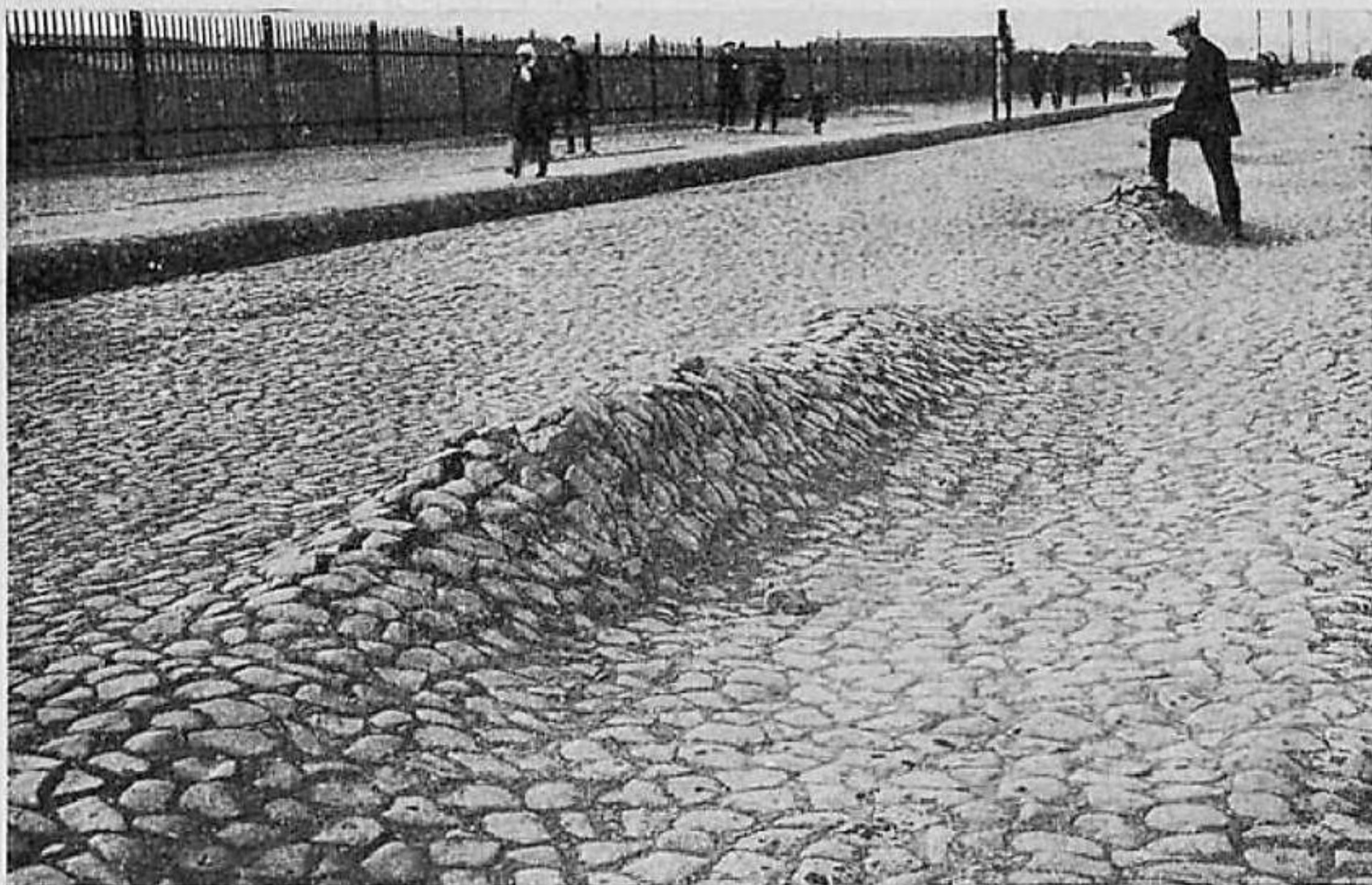
Мостовые Москвы. Автобусное движение способствует появлению пучин на булыжной мостовой (Бутырский Камер-Колежский Вал)
