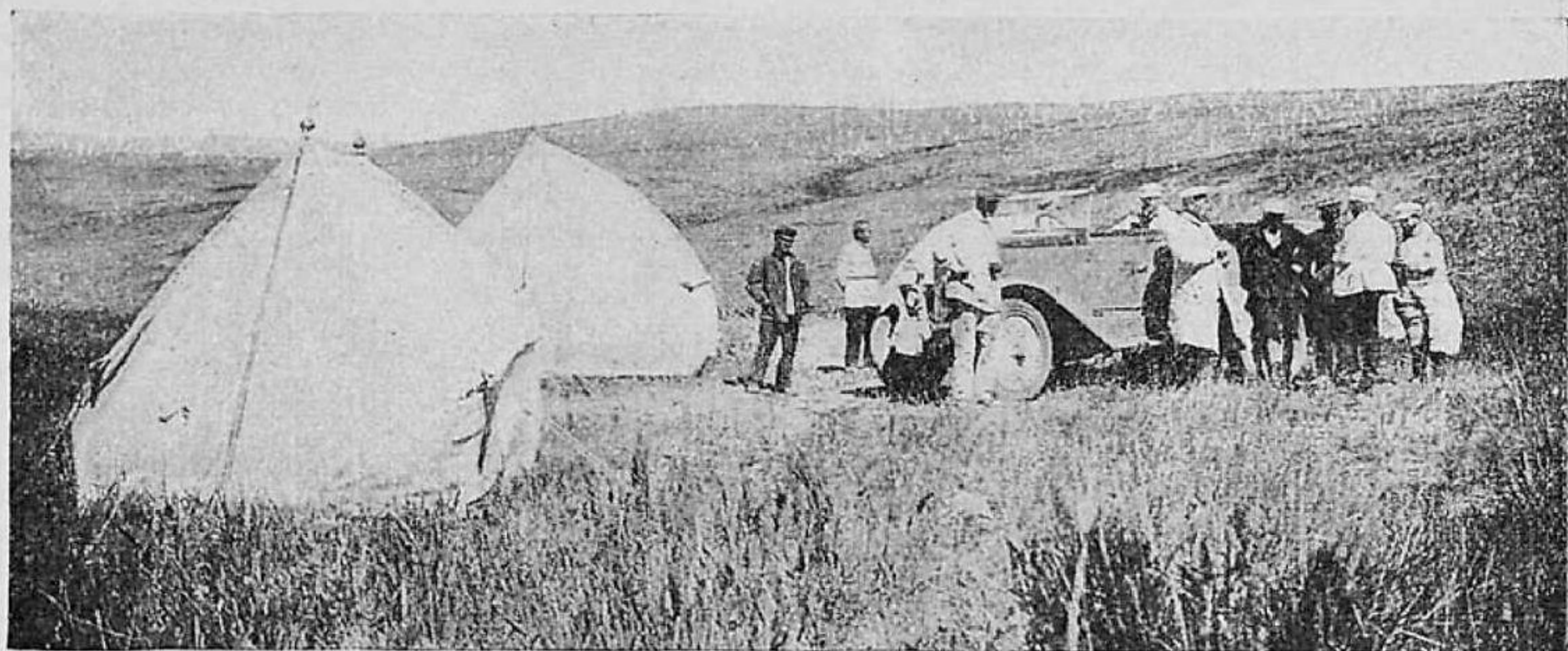
На стройке Турксиба. Автомобиль прокладывает дорогу... железной дороге. На участок будущих работ приехал изыскательный отряд
