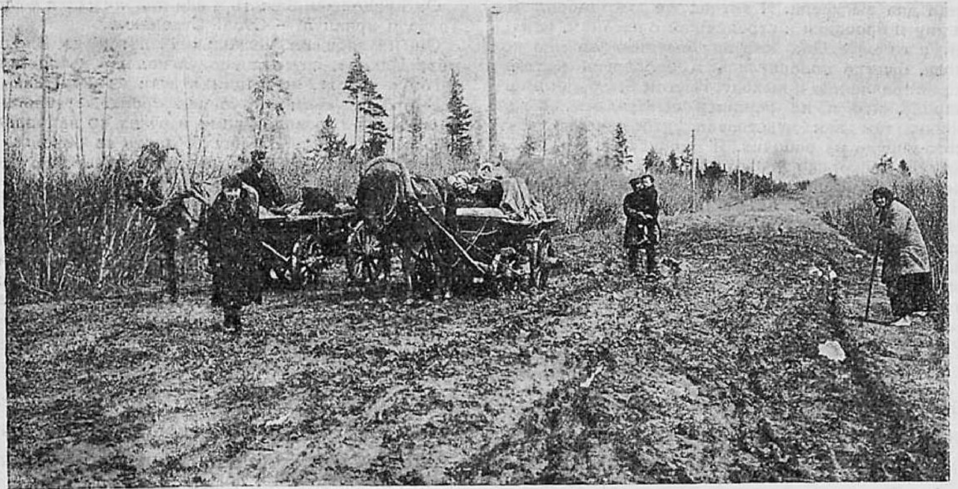
Родная картина. Типичный вид грунтового тракта (Старорусско-Холмский тракт Новгородского округа Северо-Западной области), сплошь изрытый колеями колес
