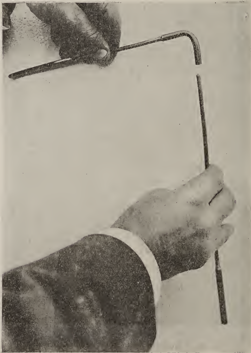
FIG. 4. — Façon d'ajuster l'une à l'autre deux pièces de la monture.
