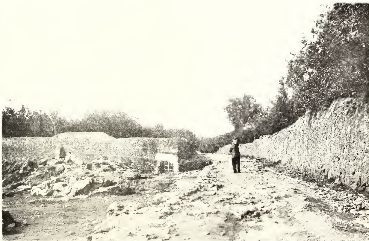
Muro di cinta del podere Casalotto. — Il segno \perp nello sperone indica l'inizio del condotto sotterraneo che porta la miscela delle acque alla tribuna S. Antonino.
