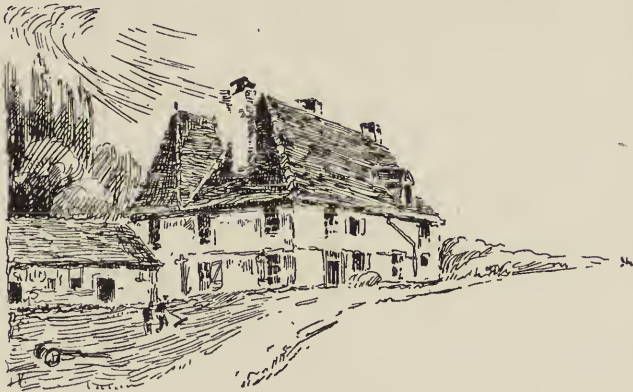
A SAINTE-FOY DE MONTGOMMERY. FACE ANTÉRIEURE DU CHATEAU.
