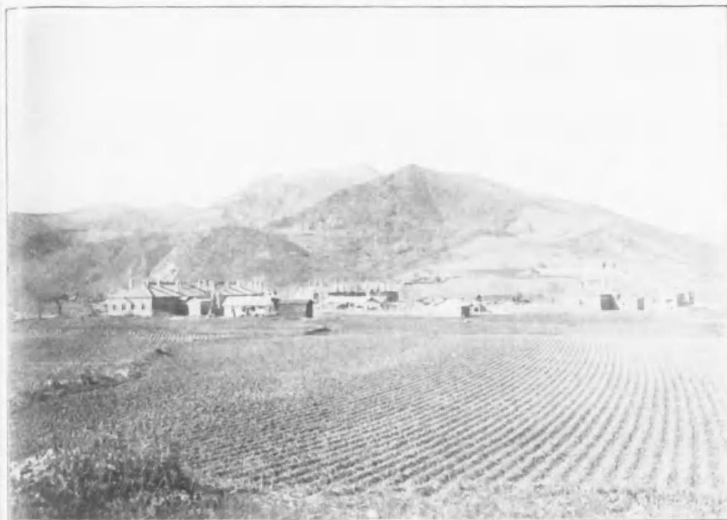
萬り成に飯築改奉安や今てはのしるわざに日今てし用利な營制の代時役戰露日は舍兵隊備守る在に繪滑奉安妹圓如に間中の露雨若新し榮響な理地に从局當しべふいとりな熱當亦るた見を築新の營兵すさんら全備設の般く聞としべむしせ轉移に處此を隊中營二備守の口河草城鳳鳳頃の夏初年三正大り成築建の造石瓦
