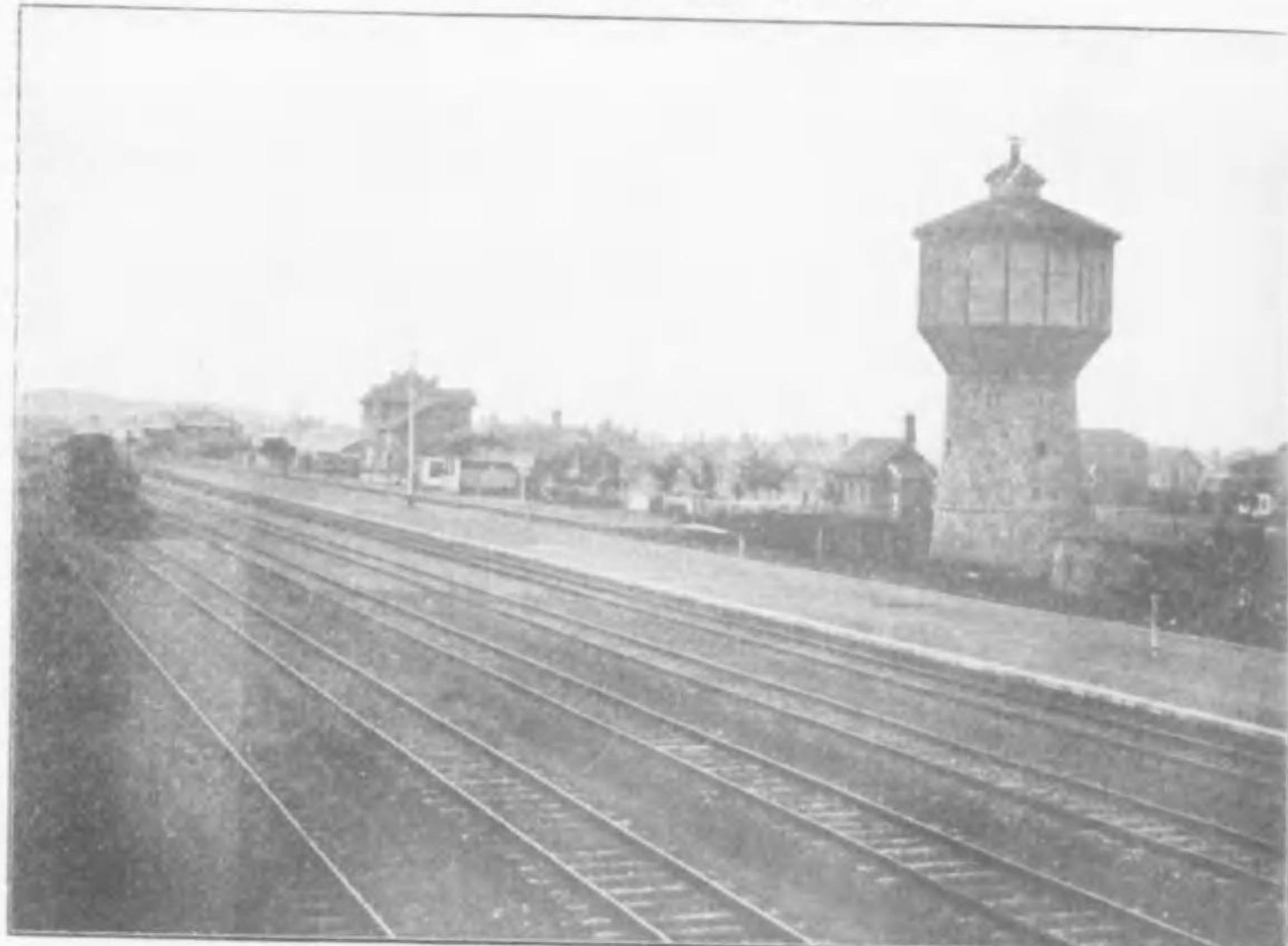
令司場車停軍露南停の時當處しせ領占の團旅備後溥傳て依に戰擊道半夜の日五十月三後戰會大天奉は場車停露俄 災の融視びた三は物業建該降以しせ毀殘な場車停てつ款を大際の却退軍露附大「フエー・ヨシワ・ゲンサキレア」官 りせ新一日面てれらせ修改く悉や今「しり羅に
