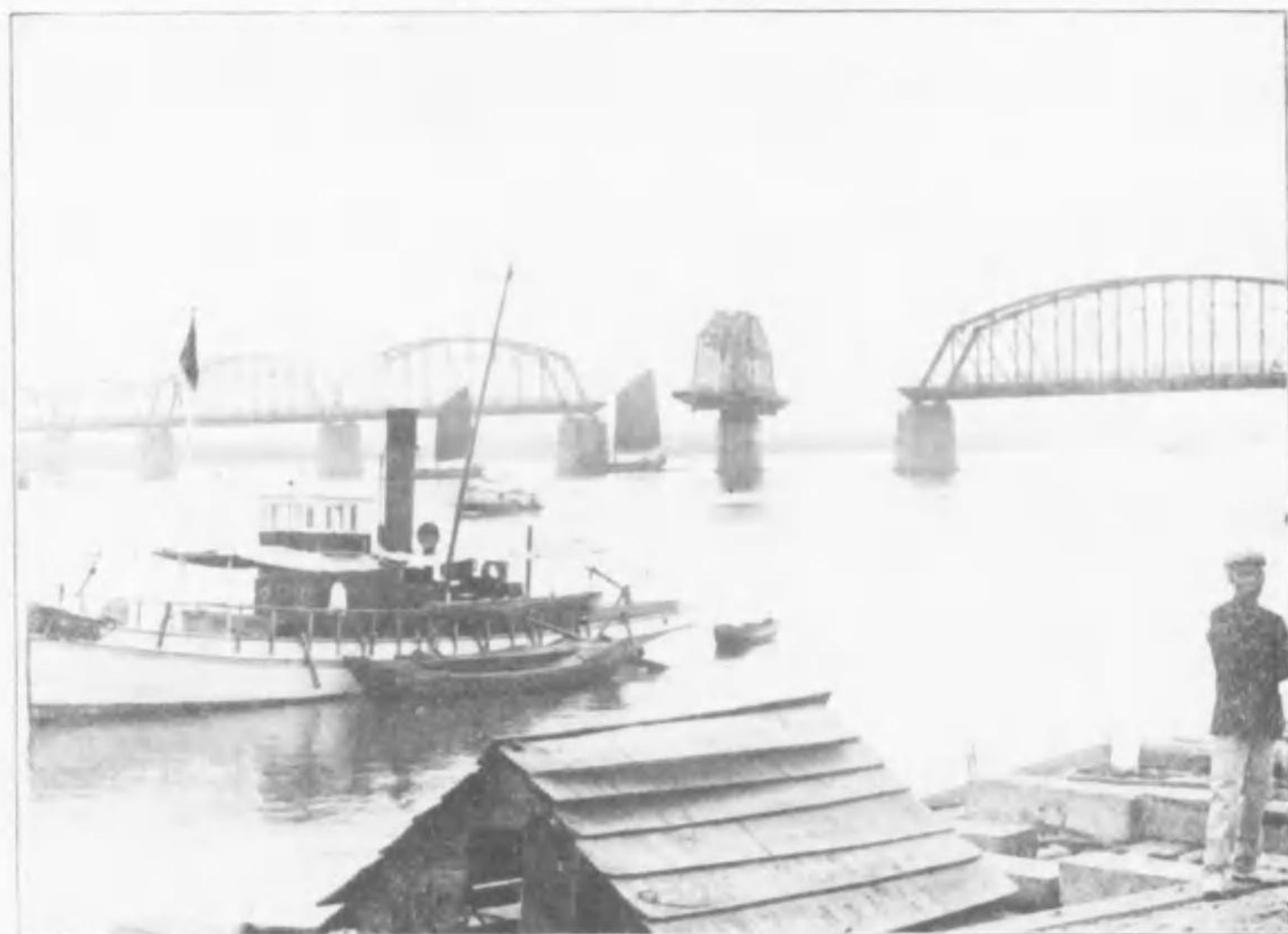
東安船汽の噸千二りよに成完の道鐵奉安時登しべす算を餘千二に常船克戎の往來に上江一の江大二洲滿は江綠鴨 りな景光の開轉其は圓しべる知て以姿の裝置閉開に橋鐵りれ至にる入に頭橋
