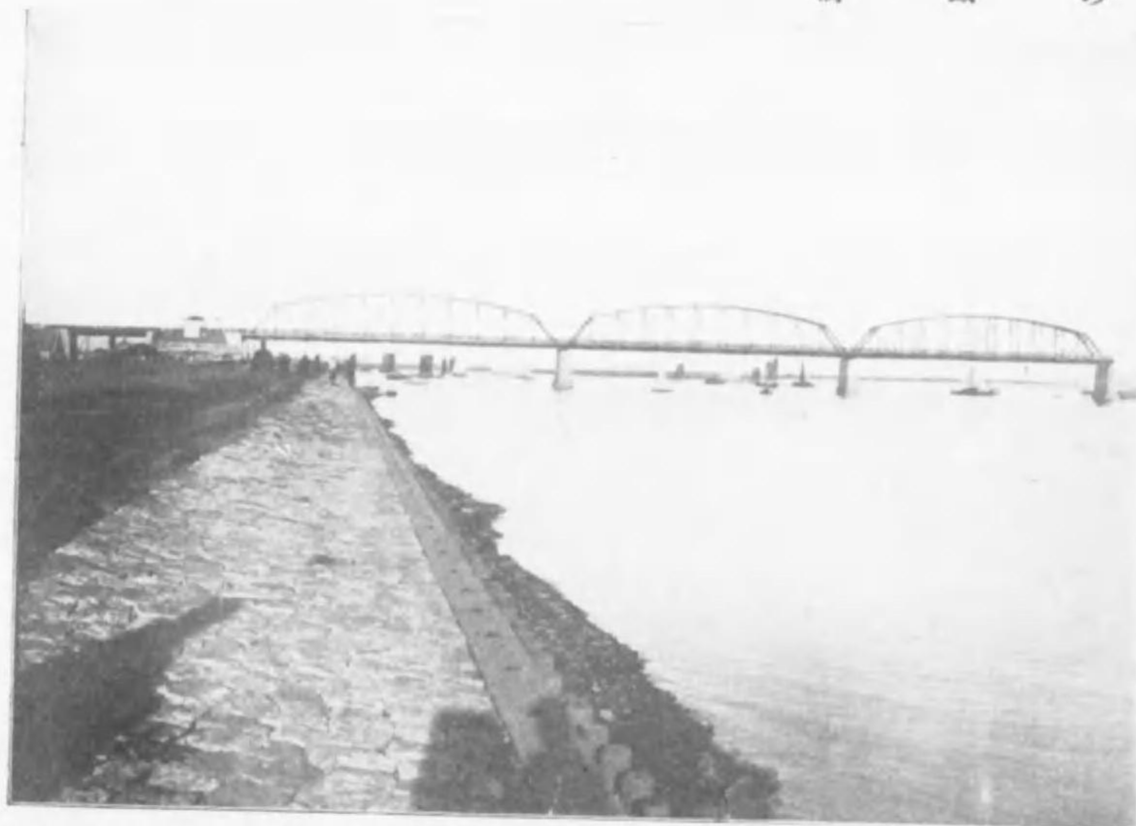
置裝る得し閉開に在自は桁橋一るけ於に央中其りあ二十湖橋沢七十九〇千三長全な橋鐵の一第岸東に實のもし りなのもしせ影場を橋全其に圓りな驛終の道鐵貫縱朝鮮てしに州義新は岸對むしせ俸祖に由自てしな
