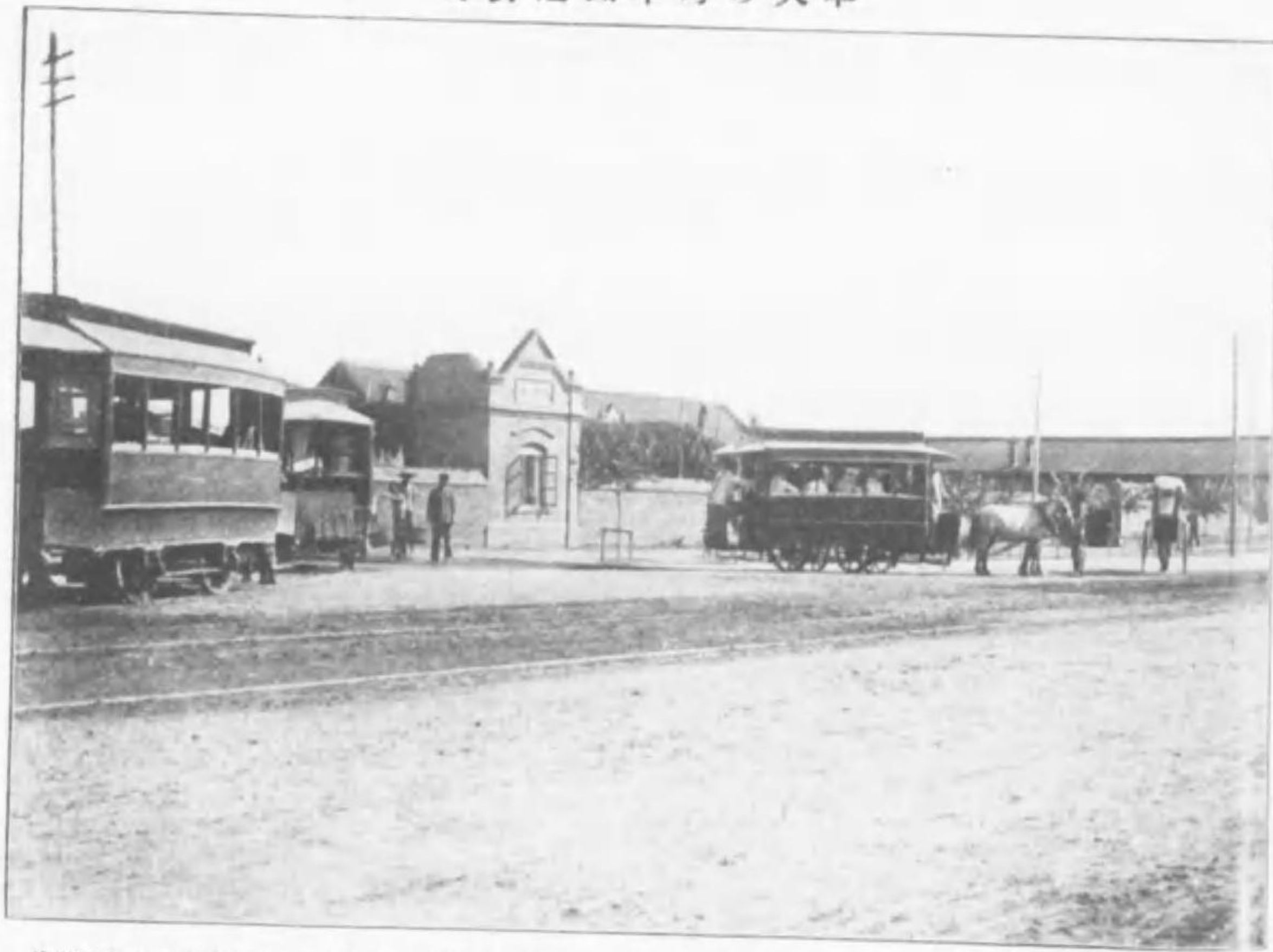
前以年十二に共體車發軌てしに業事附合の支目は司公道鐵車馬馬路の天奉とせ業開りよ且元月一年一十四治頭 奉るな便不測機通突りせ復往を問唯二約る至に關西小りよ前馬車停天奉てにのしるせ終なしあり設敷に都帝奉 みのるも道鐵車馬此唯はるれ取を路聯の問地屬附内域て於に夫
