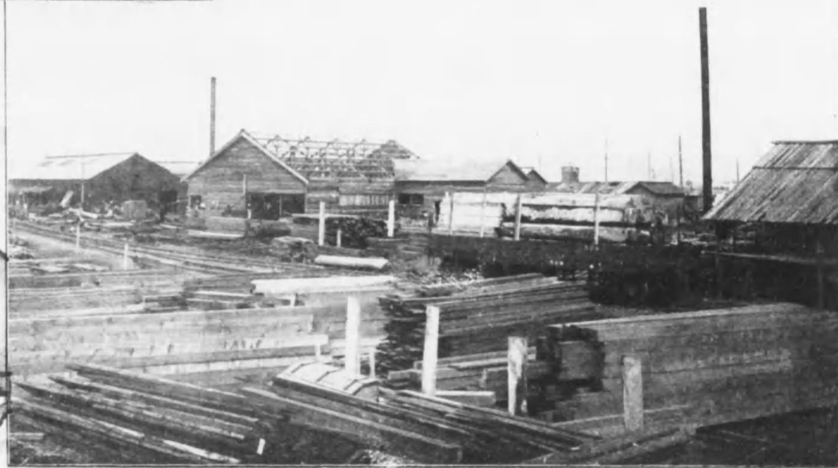
新義州營林廠製材所
