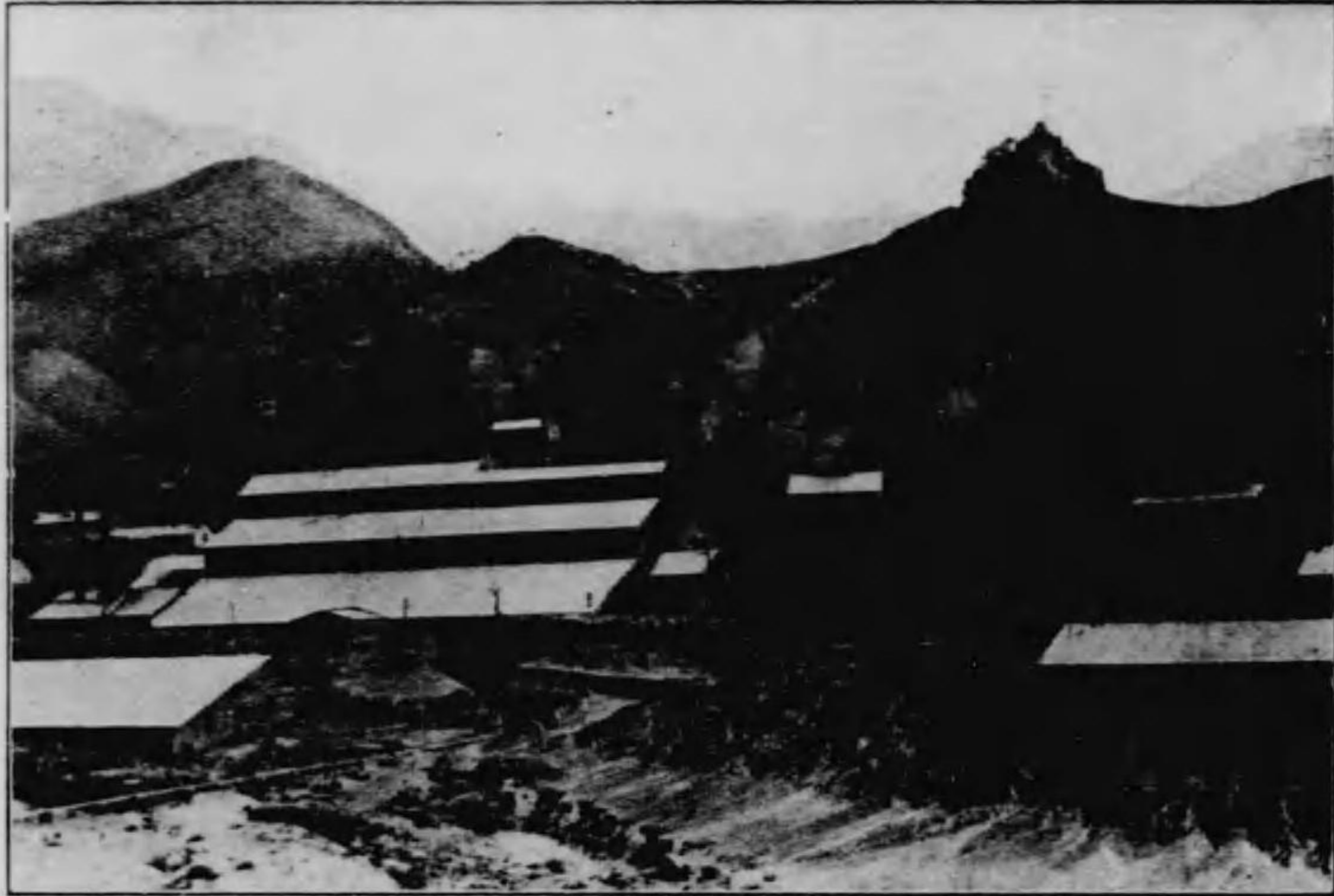
ウ、イ、タ (頭露岩大は起突の上)坑岩大山金山雲道北安平鮮朝 圖三十二百第
