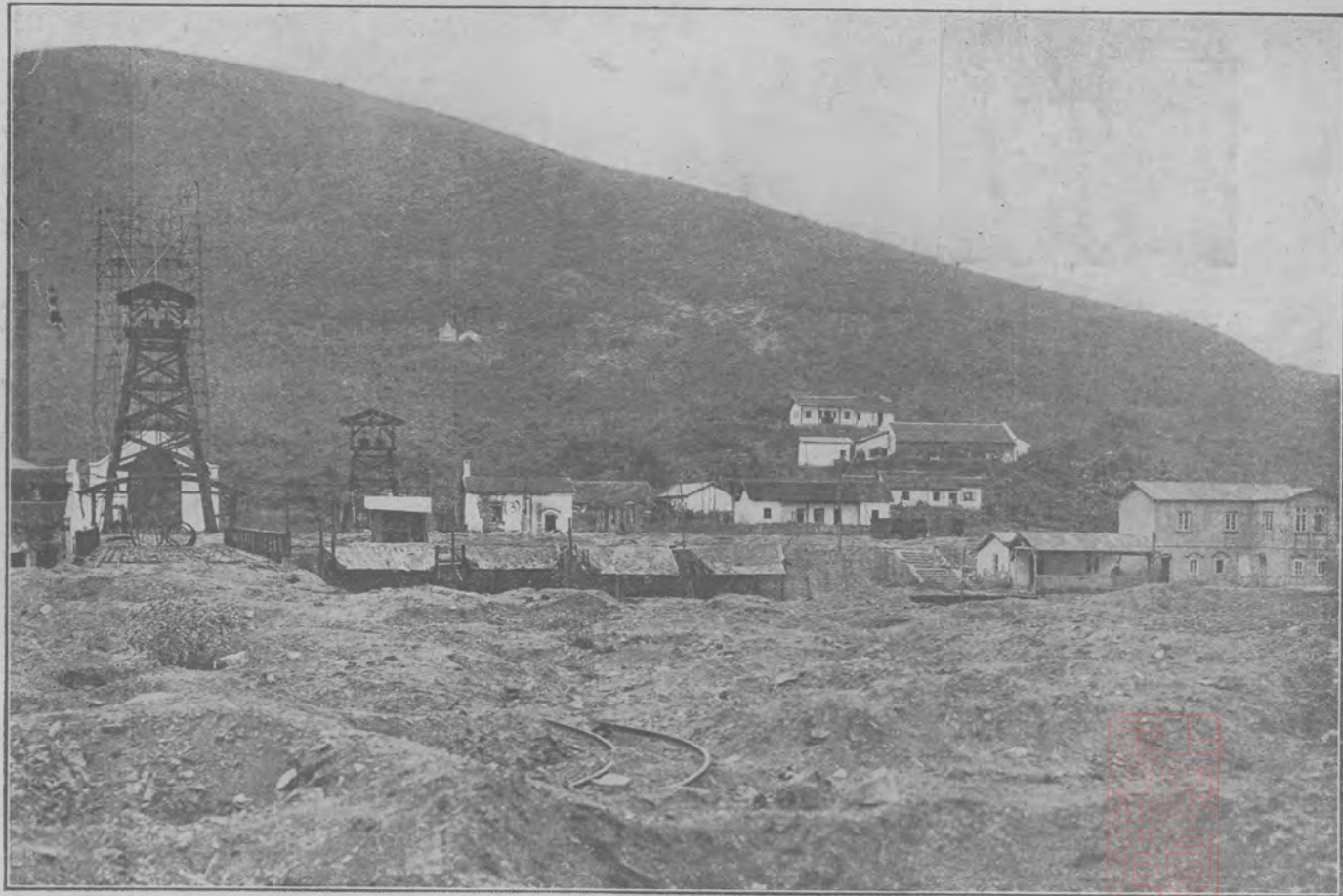
部北區鑛墩畝四鑛煤興長會員委設建
