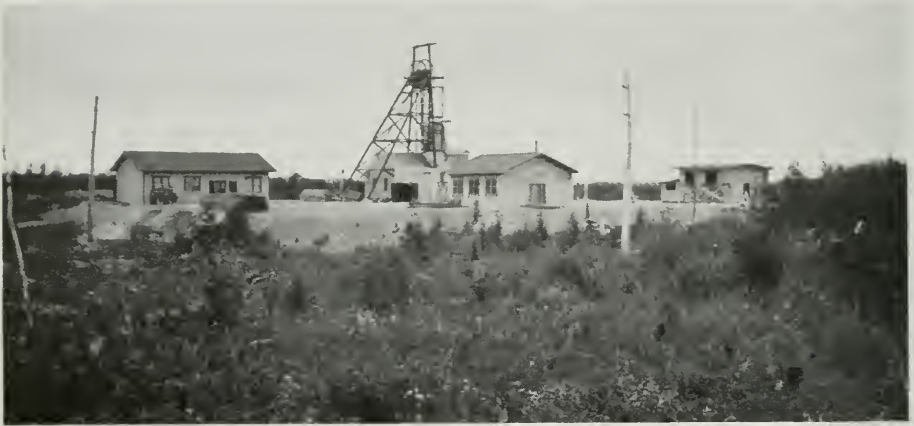
Newray mine (Coniaurum Mines, Limited).
