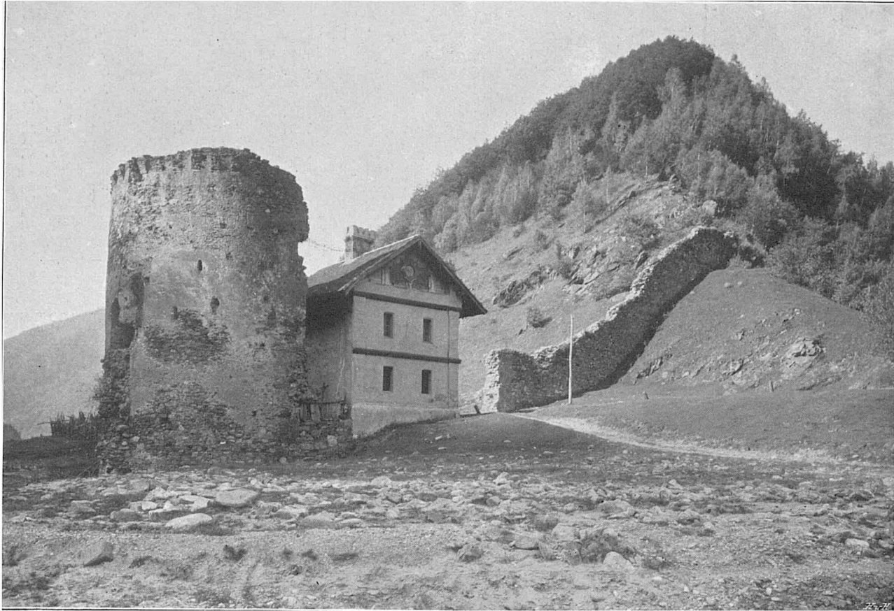
FIG. 1. VEDEREA TURNULUI SPART ȘI A ZIDULUI DE APĂRARE.
