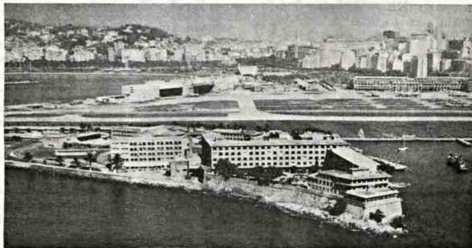
Vista aérea da Escola Naval, RJ.
