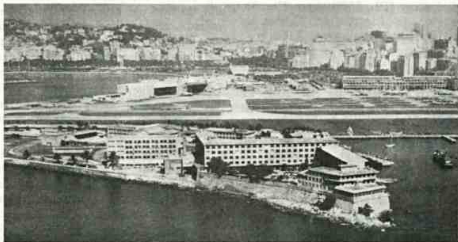
Vista aérea da Escola Naval, RJ.
