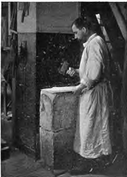
Fig. 10. — Le Batteur aplanissant une battée.
