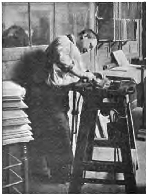
Fig. 22. — ENDOSSURE ; Formation des mors au marteau.
