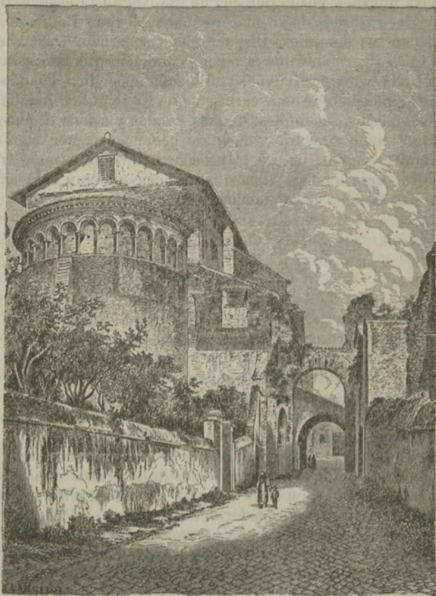
Fig. 15.—Calle y ábside de la iglesia de San Juan y San Pablo, en Roma.
