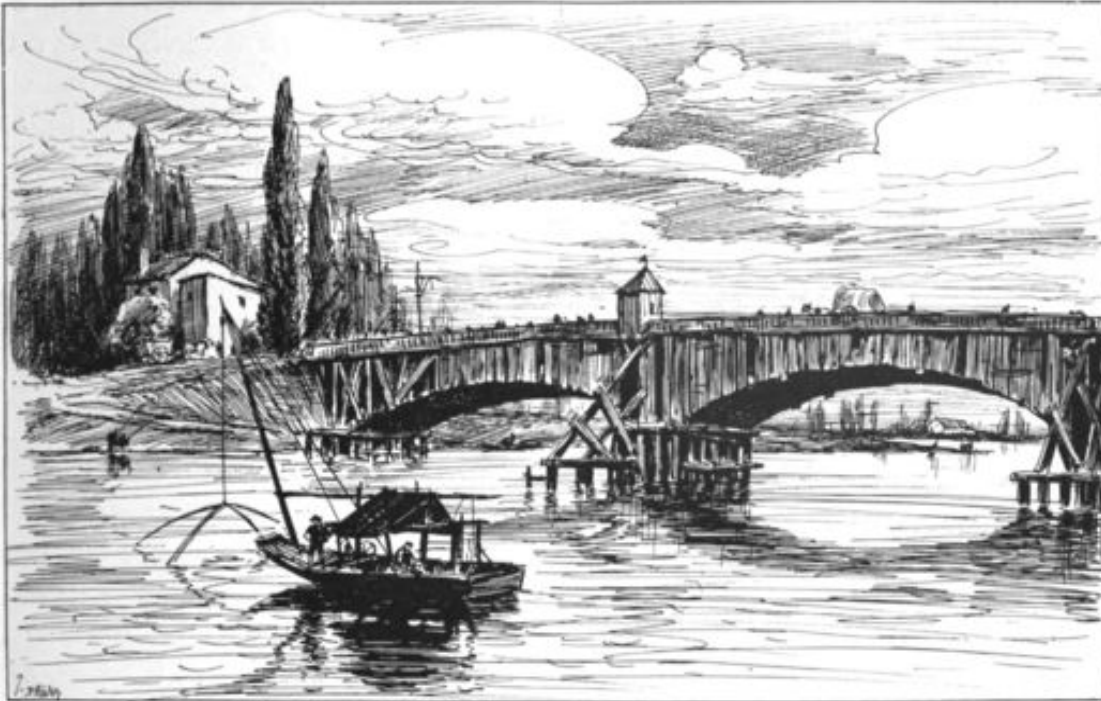
LE PONT DE BOIS DE LA MULATIÈRE, COMMENCÉ EN JUIN 1789 ET ACHÉVÉ EN 1792.
