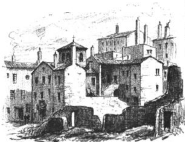
COUR INTÉRIEURE DE SAINT-PIERRE-LE-VIEUX le long de la rue de Talaru, lors des démolitions de cette rue en 1865. D'après un croquis de Paul Saint Olive.
