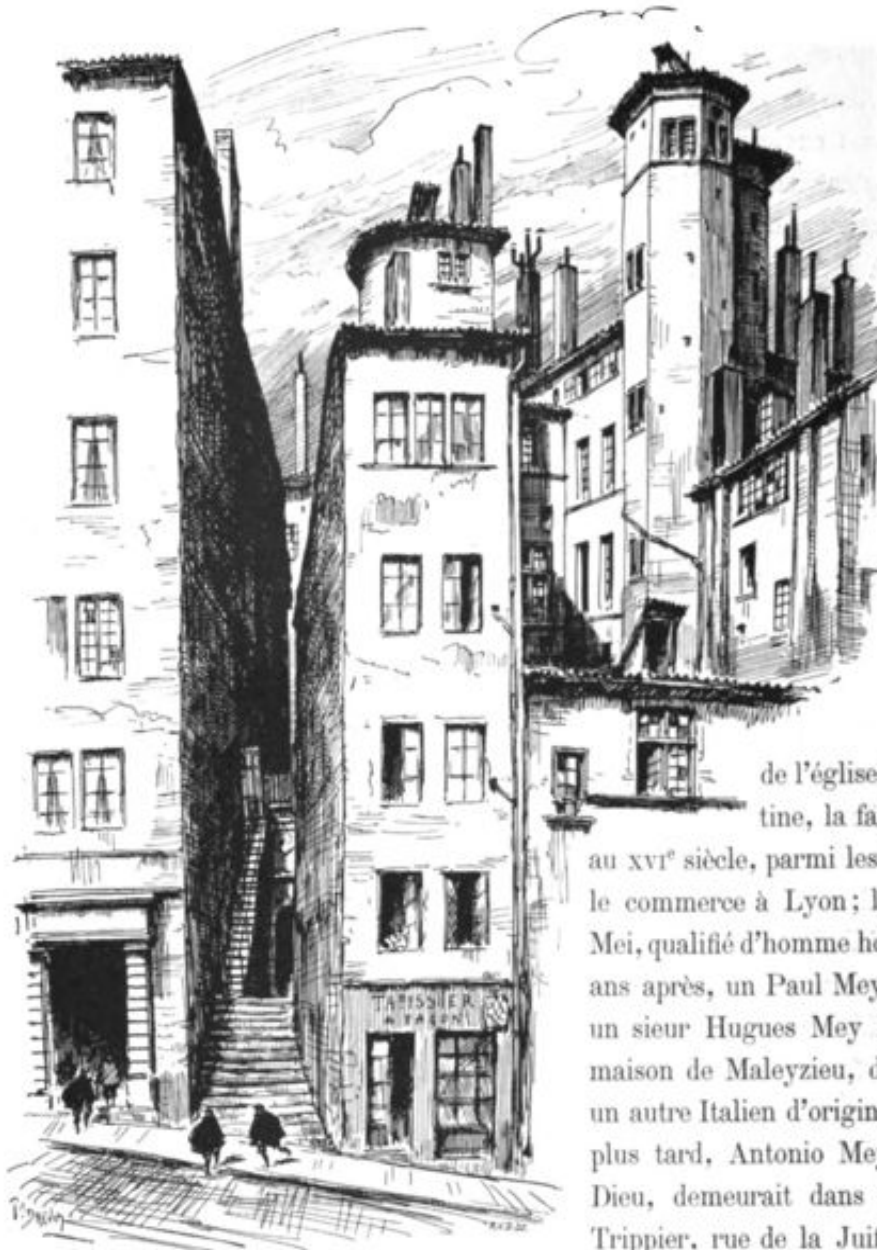
LA RUELLÉ OU IMPASSE MATAFELON, AU BAS DE LA MONTÉE SAINT-BARTHÉLEMY, ET LA MAISON A TOURELLES DITE « CHATEAU MILAN » (démolie en 1898).
