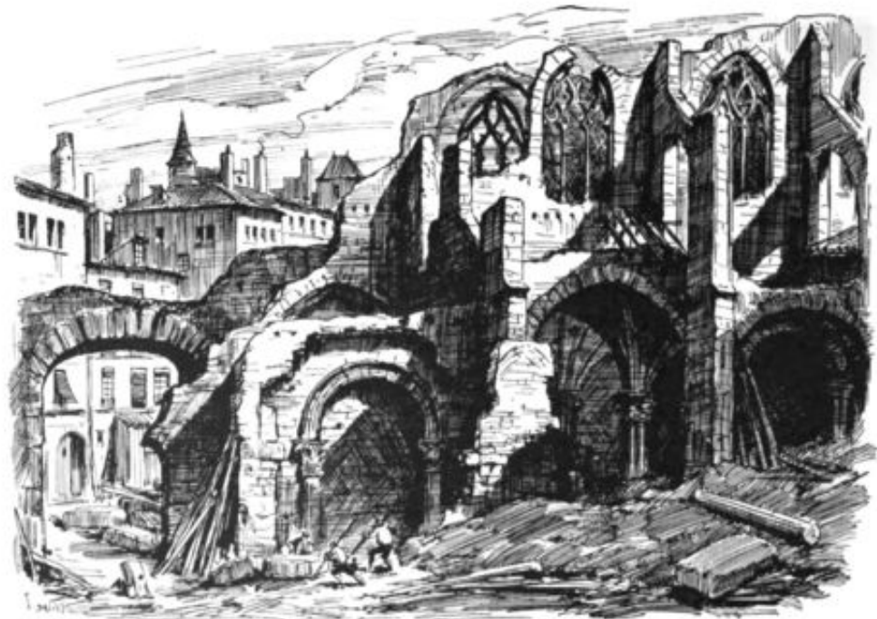
DÉMOLITION DE L'ÉGLISE DES JACOBINS, AU MIDI DE LA PLACE DE CE NOM, EN 1817-1818.
