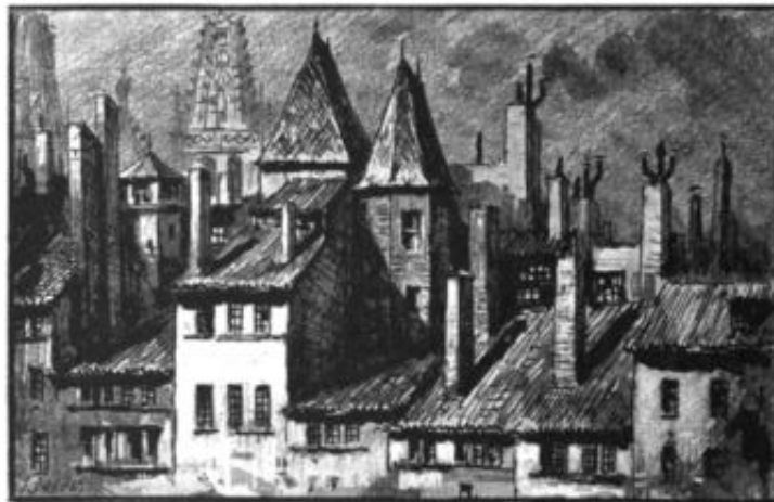
TOURELLES D'ESCALIER DES MAISONS DE LA PETITE RUE MERCIER. Côté de la Saône. Maisons du XV e et du XVI e siècle, vues du quai Saint-Antoine actuel.
