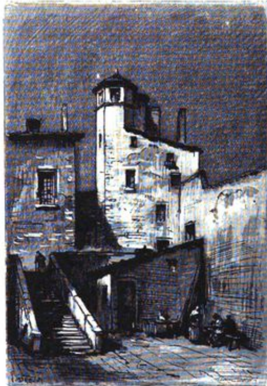
INTÉRIEUR DE LA MAISON DES CHAZAUX, démolie en 1865. (D'après un croquis de Paul Saint-Olive.)
