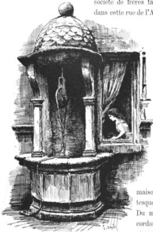
PUITS SURMONTÉ D'UN DÔME A ÉCAILLES EN DEMI-CERCLE, dans la cour d'une maison du xvi e siècle, rue Lainerie, 11. (Dessiné en 1896.)
