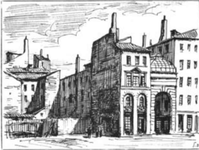
LE PASSAGE DE L'HÔTEL-DIEU (entrée occidentale) en 1860, avant l'ouverture de la rue Childebert.
