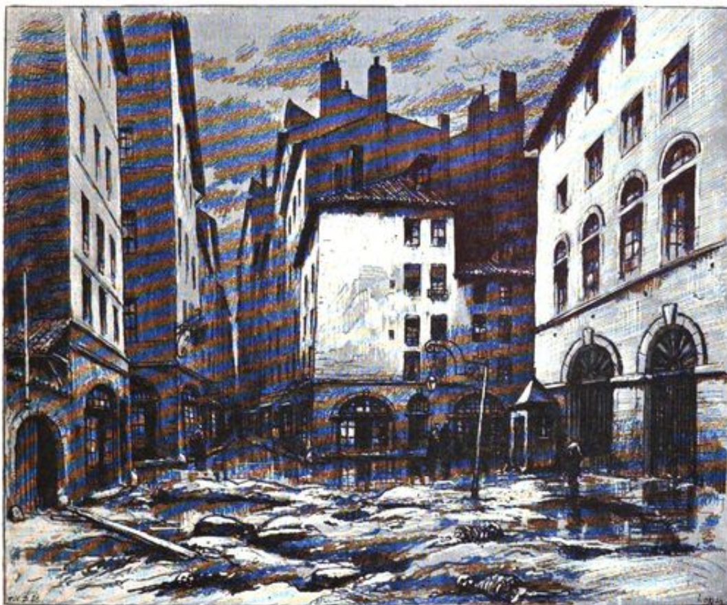
LA RUE DU PORT-CHARLET (RUE FERRANDIÈRE) PENDANT L'INONDATION DE 1840.
