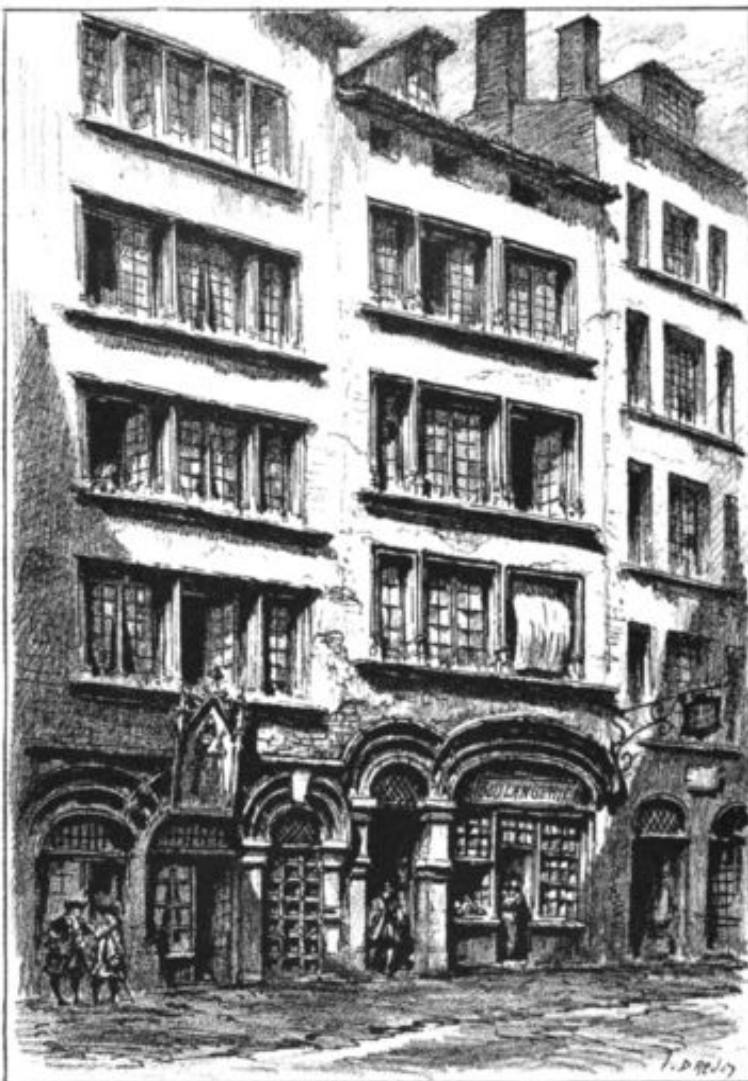
MAISONS DE LA RUE GRENETTE (N OS 27 ET 29), DÉMOLIES EN 1896. Remarquables par les « arcs à pénétration » des portes et des boutiques.
