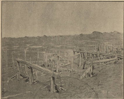
第三十五圖 發掘前之尼雅古代住宅廢址
