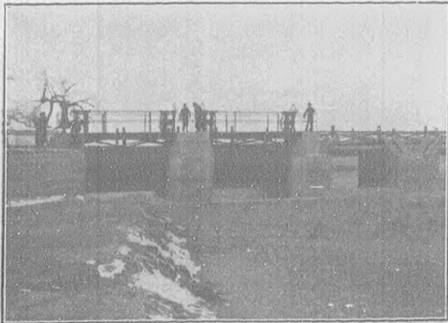
(八) 金門閘南岸放淤工程進水閘
