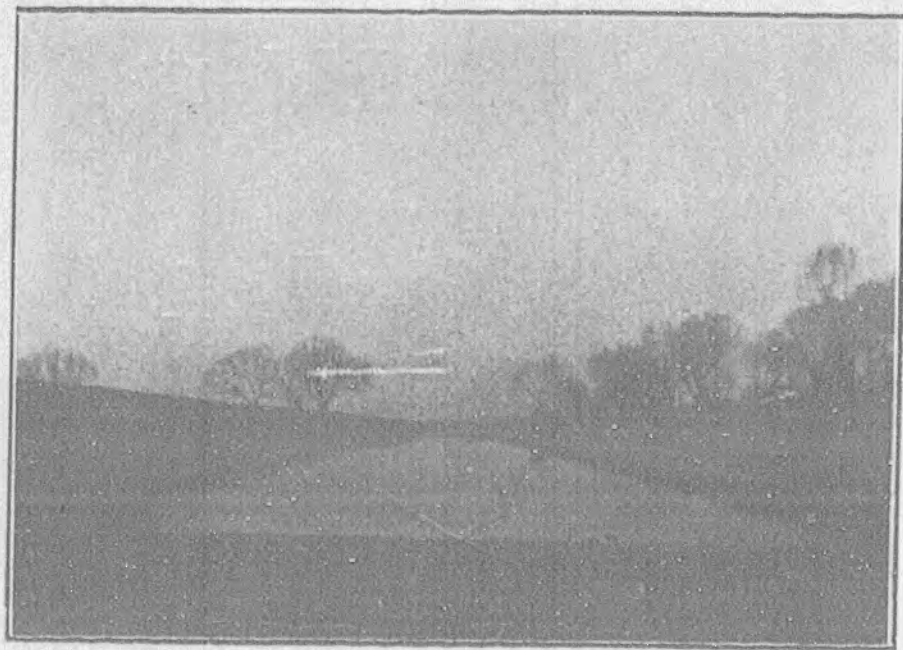
(五) 金門閘南岸放淤工程引水渠
