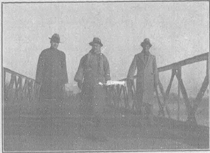
(一)本會彭委員長視察盧溝橋滾壩海漫工程
