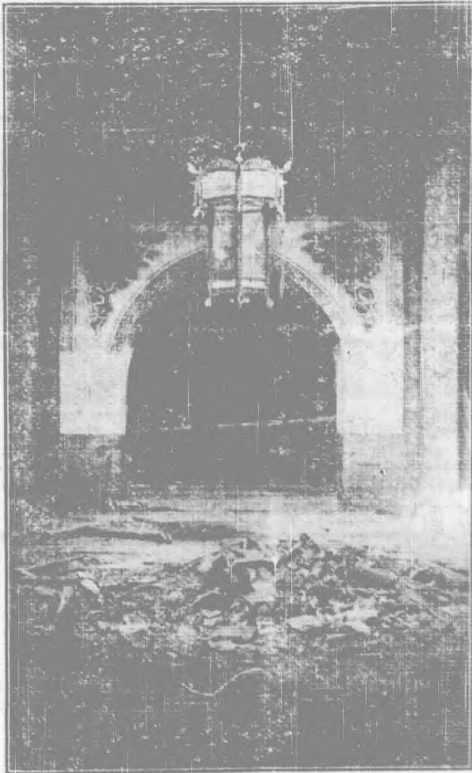
河北京通州清真寺大殿轟炸之慘狀 殿內瓦礫堆積
