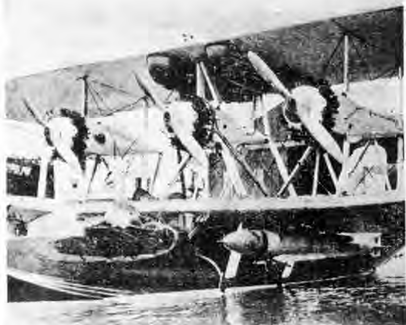
上圖爲維克斯廠製造三副發動機木質飛行艇並配置運備魚雷發射管機件
