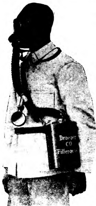
第二十七圖 一氧化碳濾毒罐連同 面具的裝置
