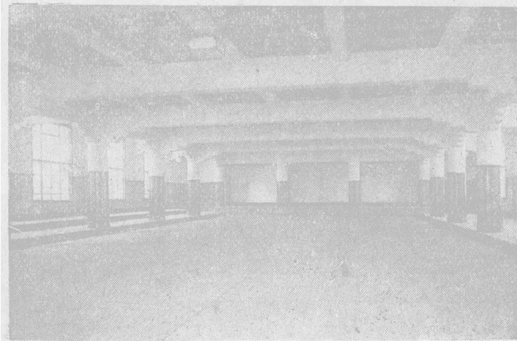
武道館中柔道道場
