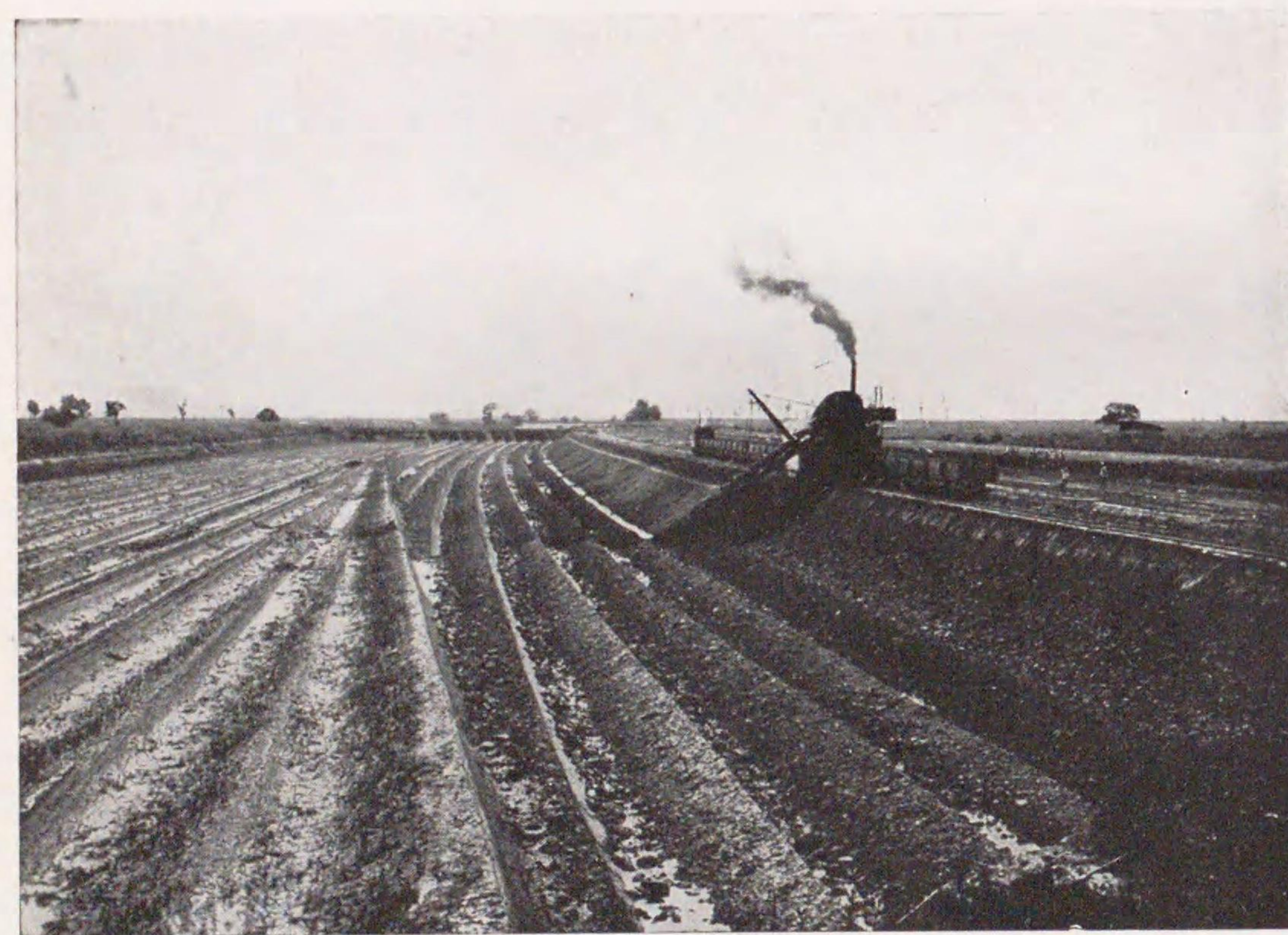
十勝川新水路の掘削作業
