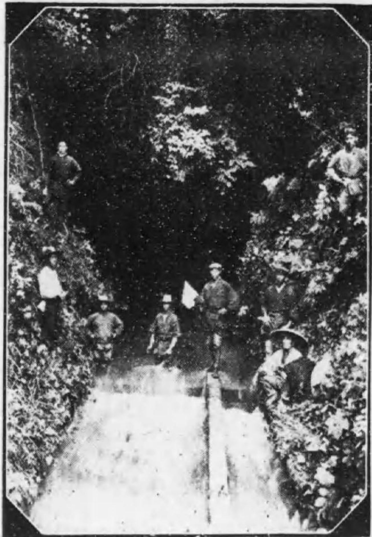
室山野用水の隧道
