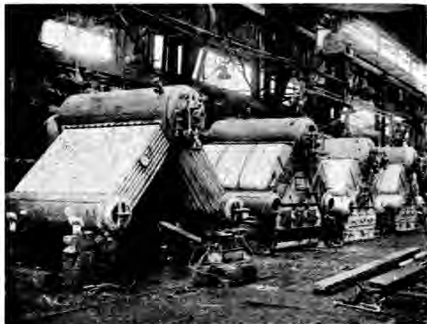
第二十八圖 製造中的雅羅牌 (Yarrow type) 水管式汽鍋
