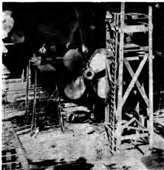
第二十二圖 用起重機裝置推進器
