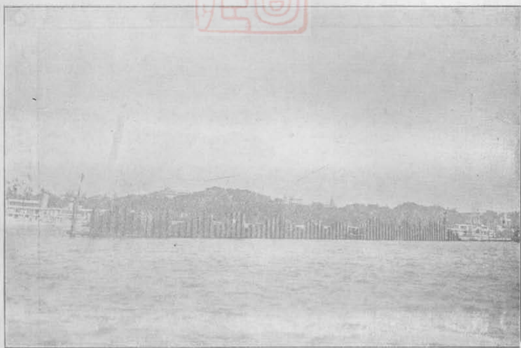
8. 內港現經打下之鋼樁
