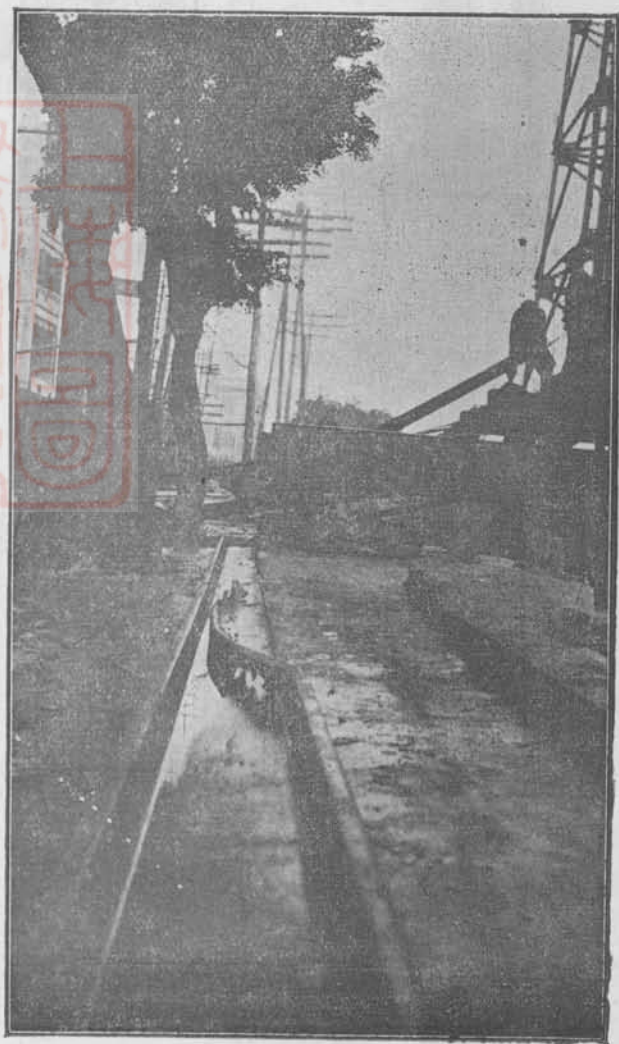
15. 建築珠江大鐵橋施工之情形
