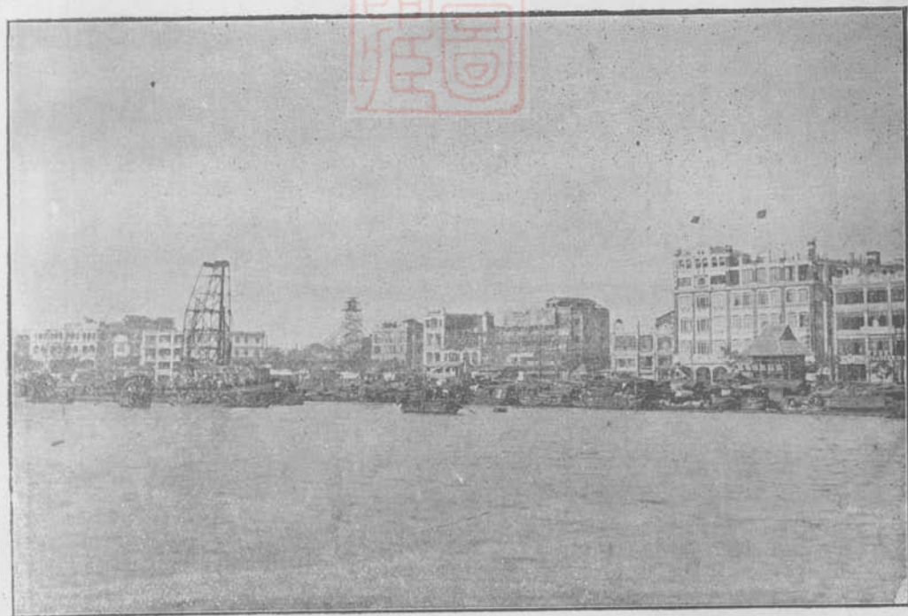
12. 填築海珠實施工作之情形 (打鋼樁)
