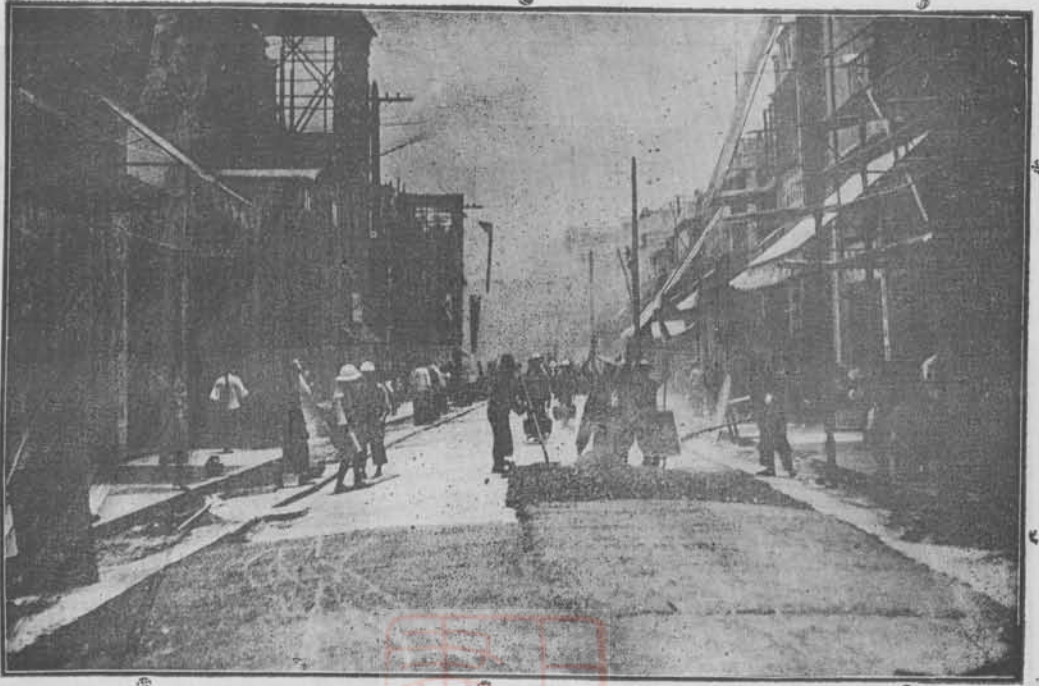
光復路鋪築青路面之情形
