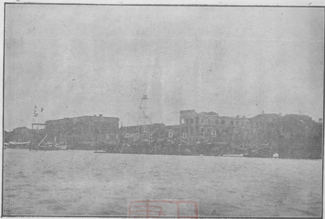
9. 建築廣州市內港施工之情形
