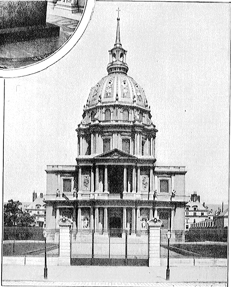
FAÇADE SUD ET DÔME DE L'HÔTEL DES INVALIDES.
