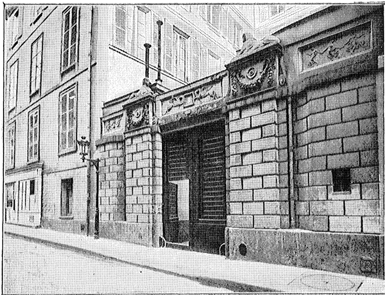
MAISON MORTUAIRE DE VOLTAIRE (1, RUE DE BEAUNE).
