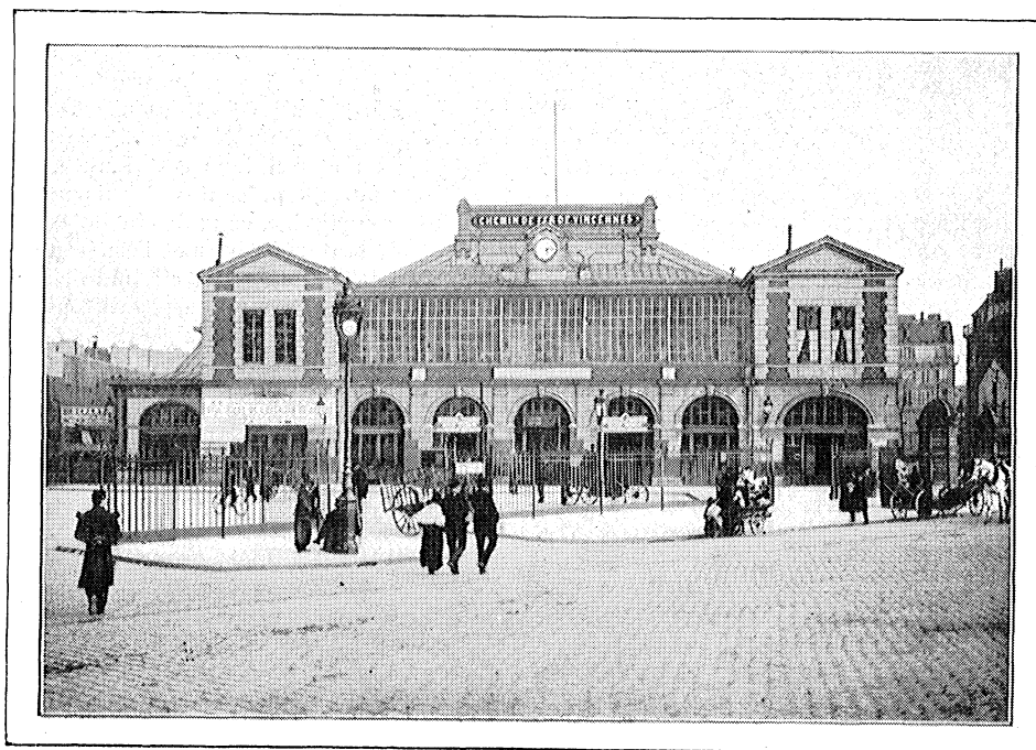
LA GARE DU CHEMIN DE FER DE VINCENNES.
