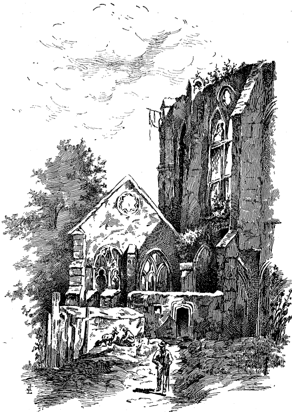
RUINES DE LA COMMANDERIE DE ST-JEAN-DE-LATRAN EN 1853.
