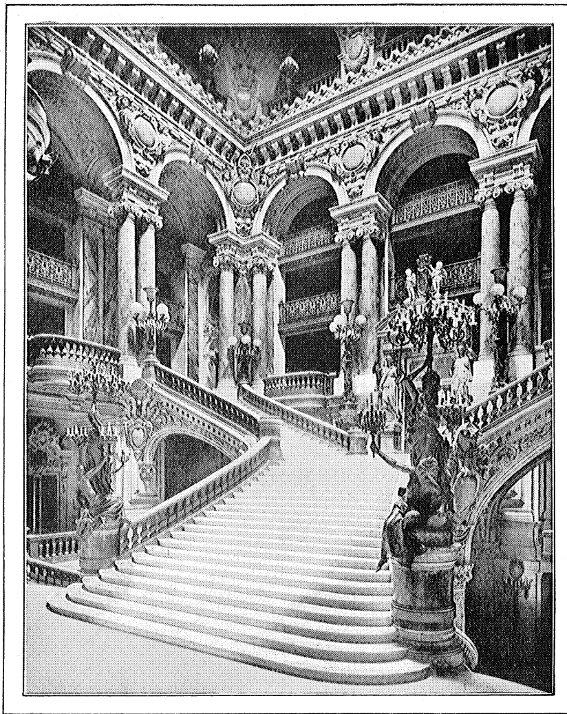
LE GRAND ESCALIER DE L'OPÉRA.
