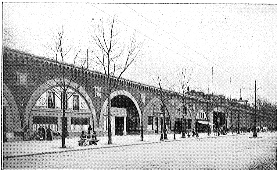
LE VIADUC DU CHEMIN DE FER DE VINCENNES.
