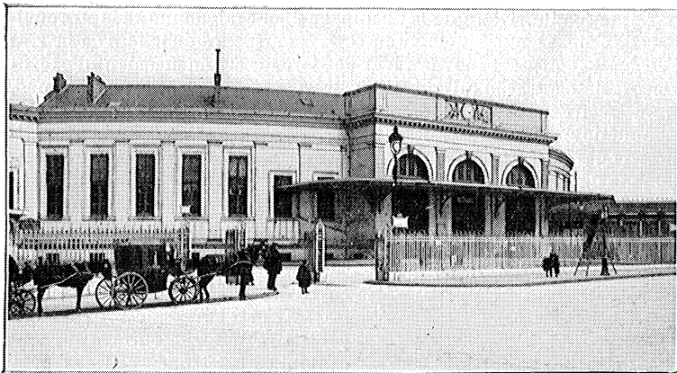
FAÇADE DE LA GARE DU CHEMIN DE FER DE SCEAUX. (STATION DITE DE PARIS-DENFERT.)
