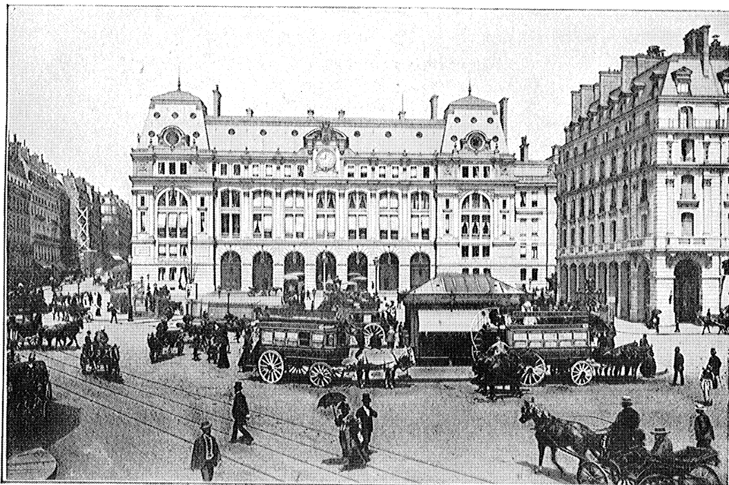
FAÇADE DE LA GARE SAINT-LAZARE (BÂTIMENT OUEST).
