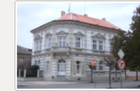
Nymburk, rohový dům na ulici Havlíčkova. jpg
