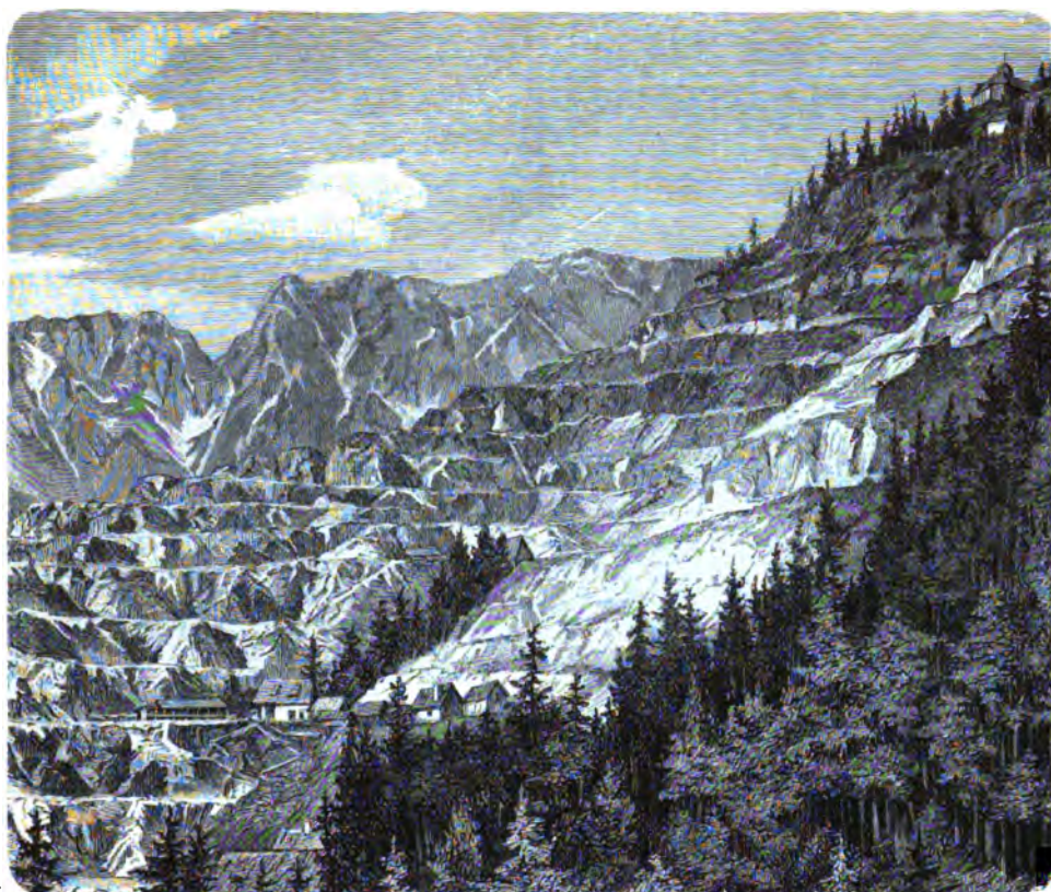
Ступенчатая разработка Рудной горы въ Эйзенерцъ, въ Штирии. Горный склонъ состоитъ изъ шпатоваго желъзняка, который добывается открытыми разработками въ нѣсколько этажей.
