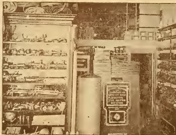
INTERIOR A. L. MORSE & CO'S—PLUMBERS.
