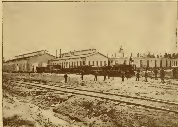
GENERAL VIEW OF MACHINE SHOPS, M., L. S. & W.
