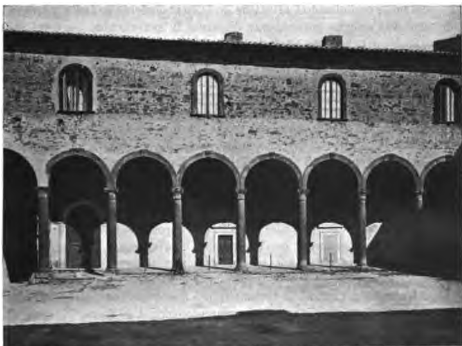
Le Portique de Sangallo.
