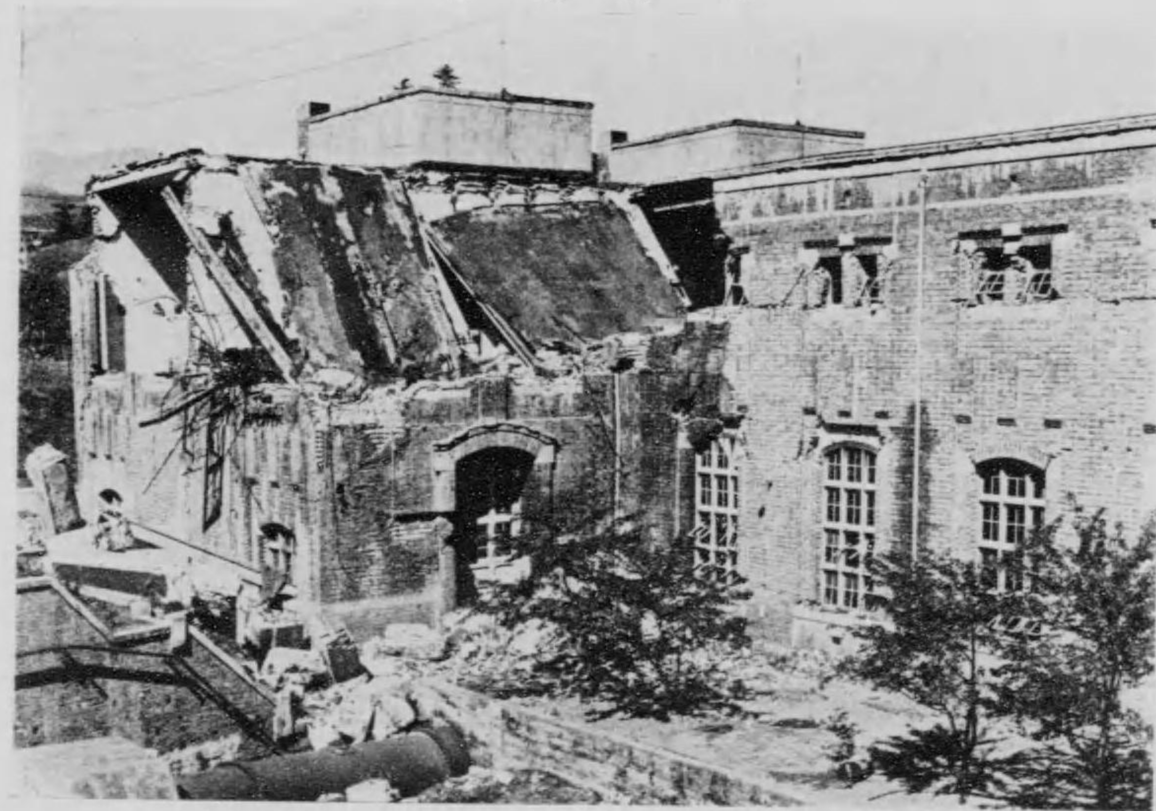
東京電燈株式會社 鹿留發電所及變電所震害狀況
