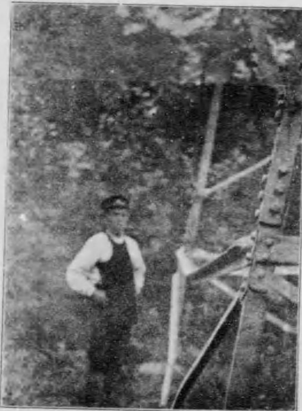
東京電燈株式会社 (桂川線) 振動のため鐵塔 プレーシングの彎曲せるもの
