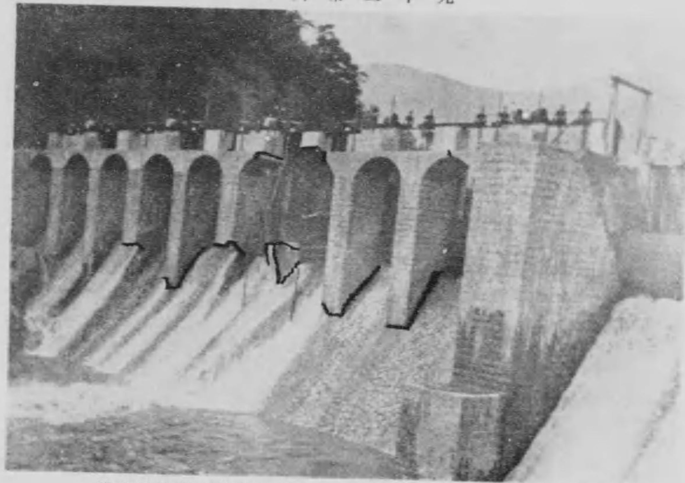
富士瓦斯紡績株式會社 嵐水力取入口堰堤被害の状況
