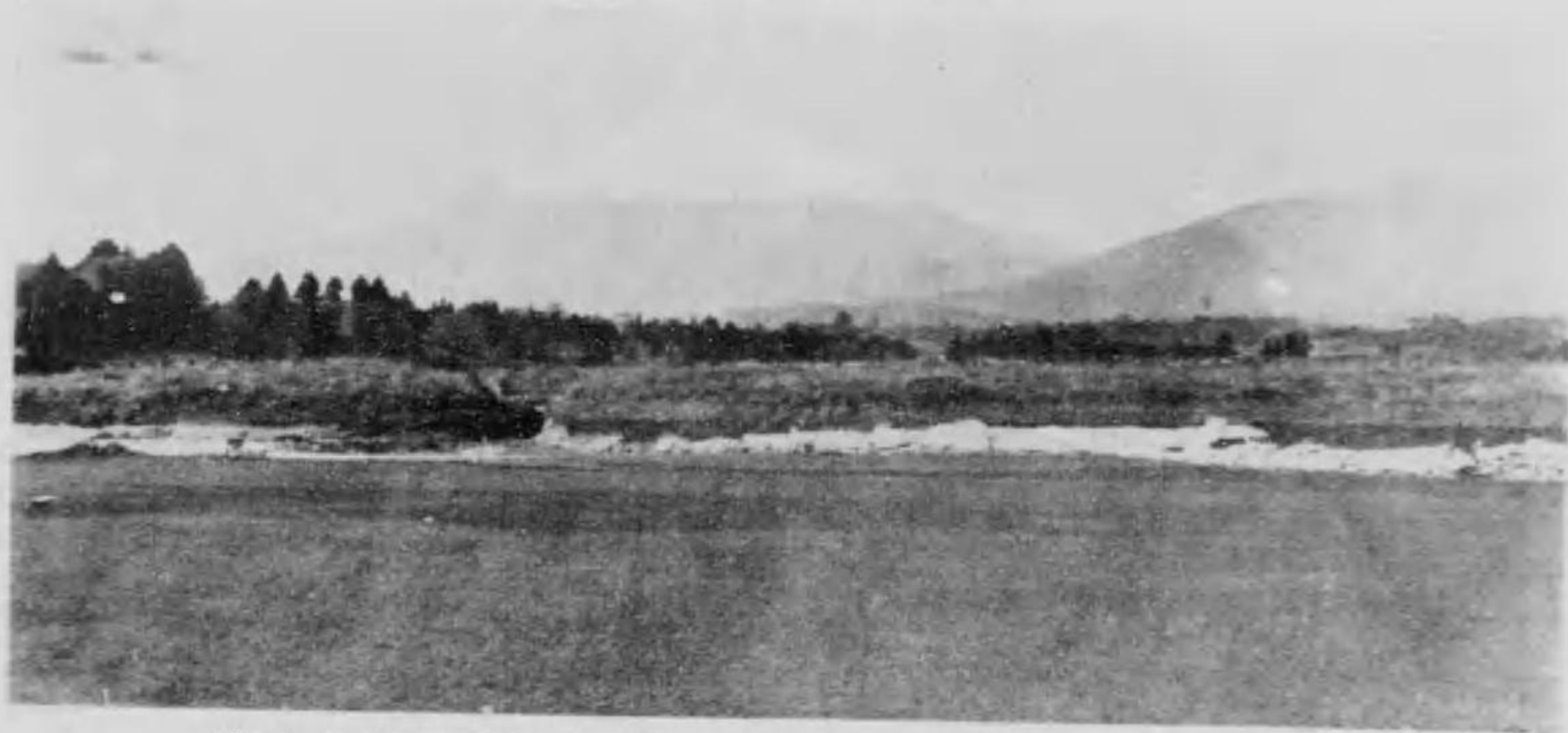
富士瓦斯紡績株式會社 須川水力調整池法混凝土崩壞
