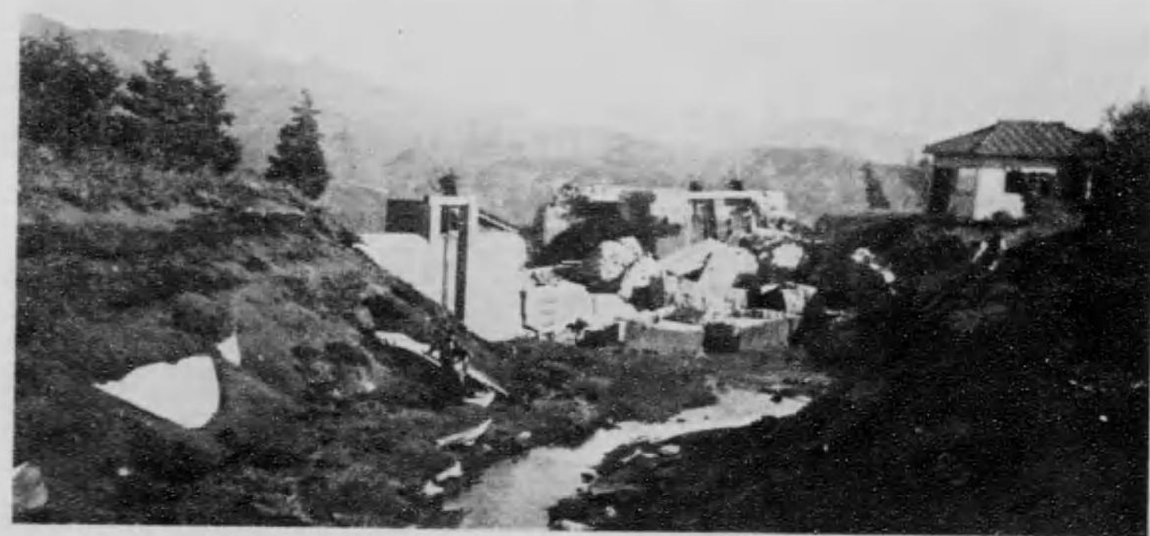
富士瓦斯紡績株式會社 須川水力水槽鐵管口崩壞
