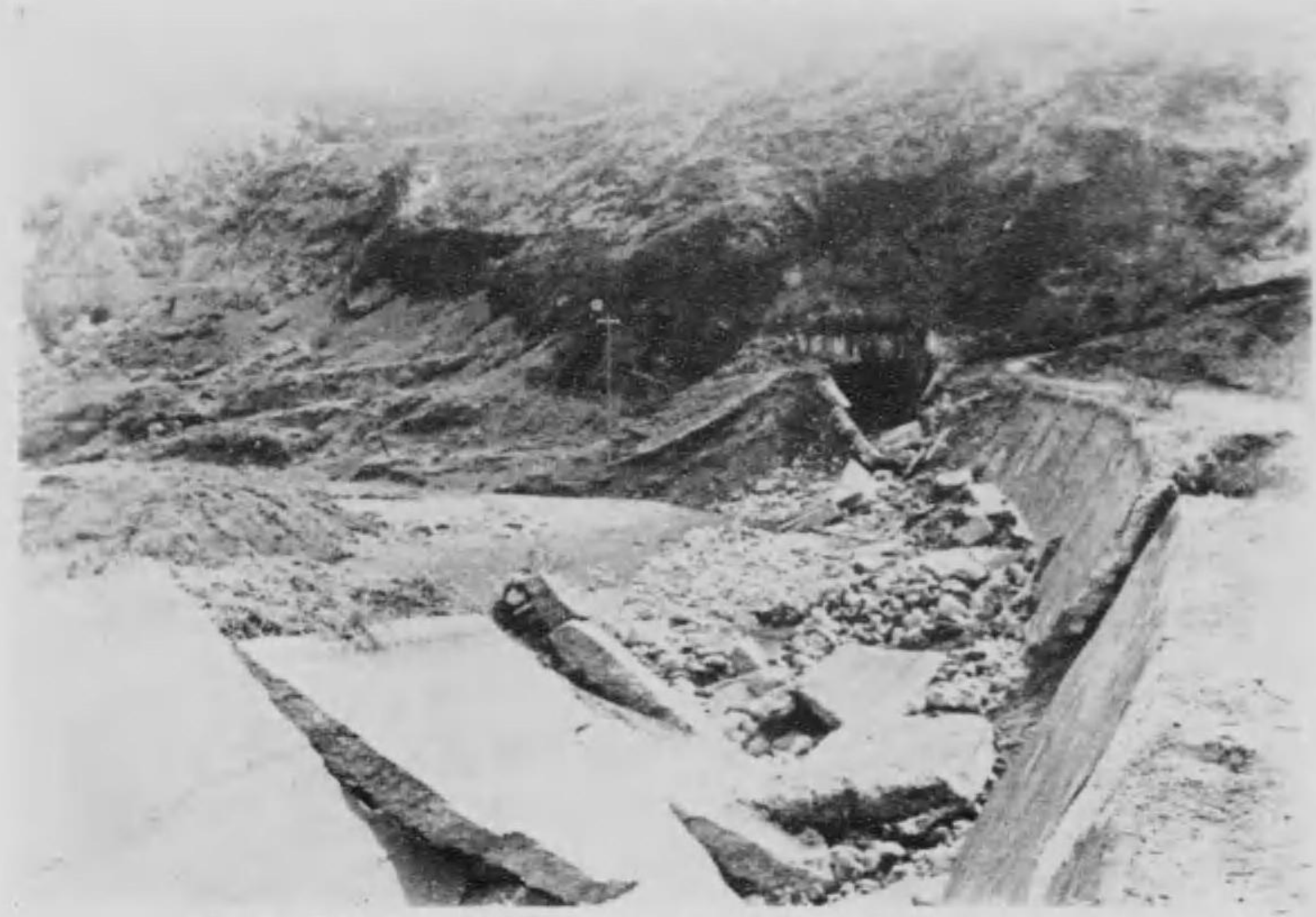
富士瓦斯紡績株式會社 内山水力第二號開渠側壁倒壊
