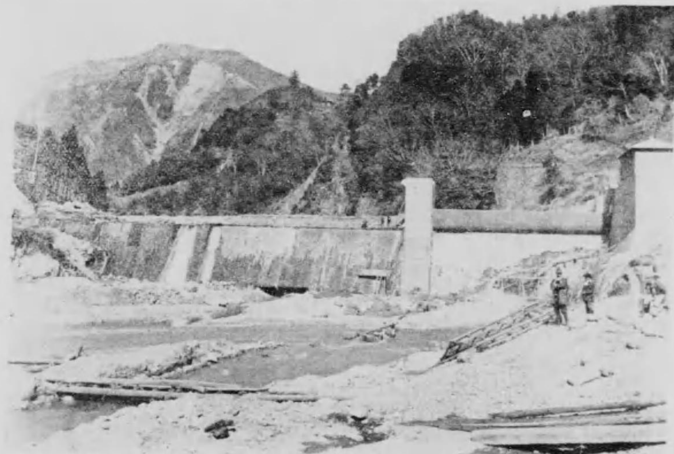
富士瓦斯紡績株式會社 嵐水力取入口堰堤水門倒壊後右方は震害を免れたるピーヤとローリムゲ・メン
