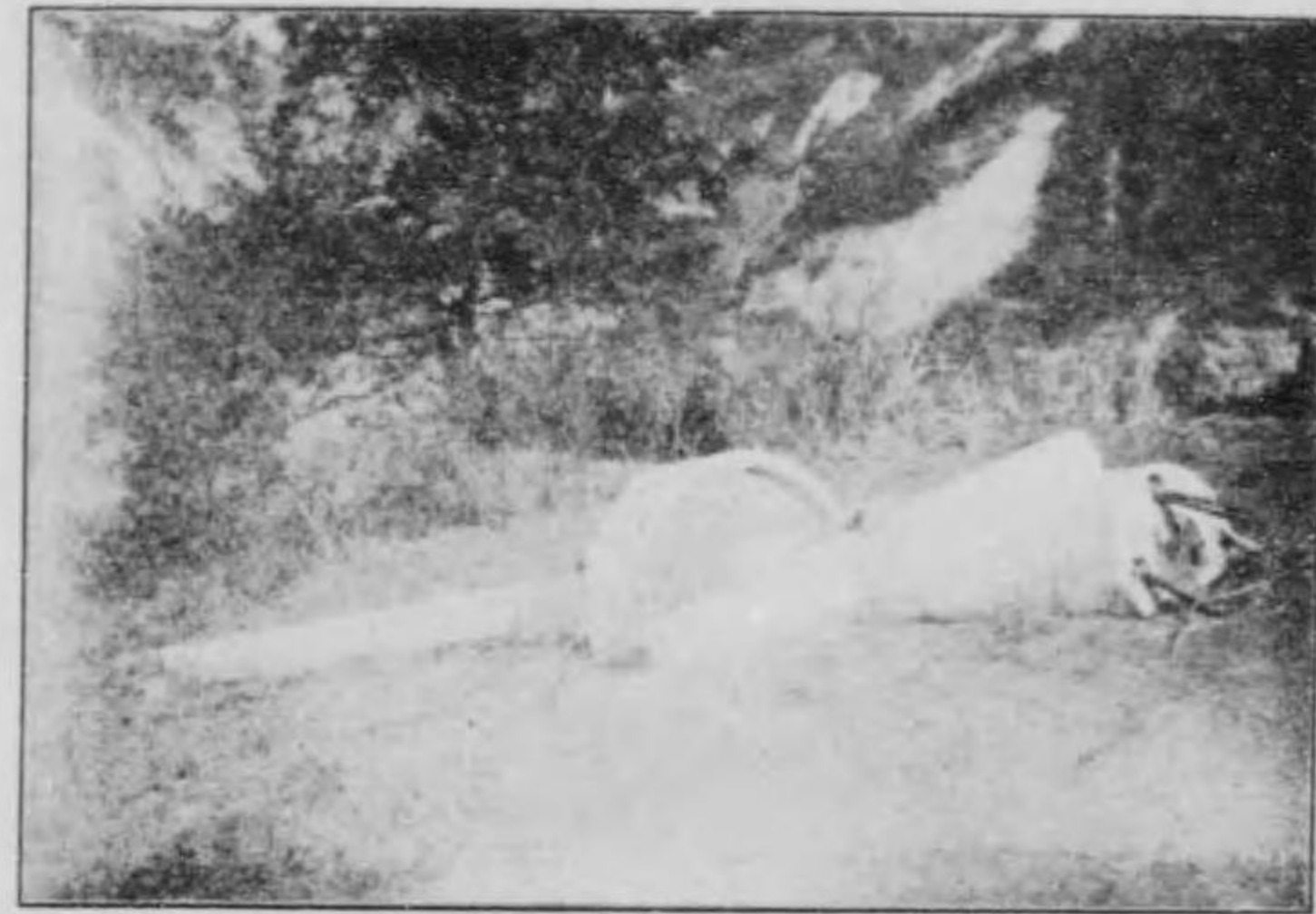
鐵道省通信線 山北谷崕間に於ける鐵筋混凝土柱の被害(第71號柱)
