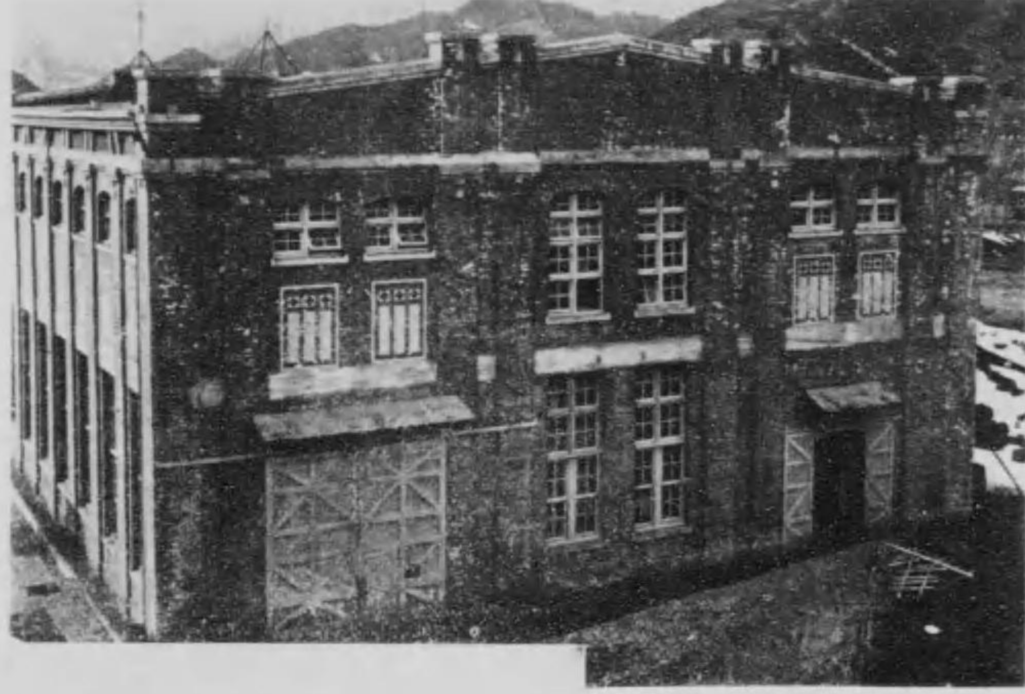
東京電燈株式會社 谷村發電所震害狀況
