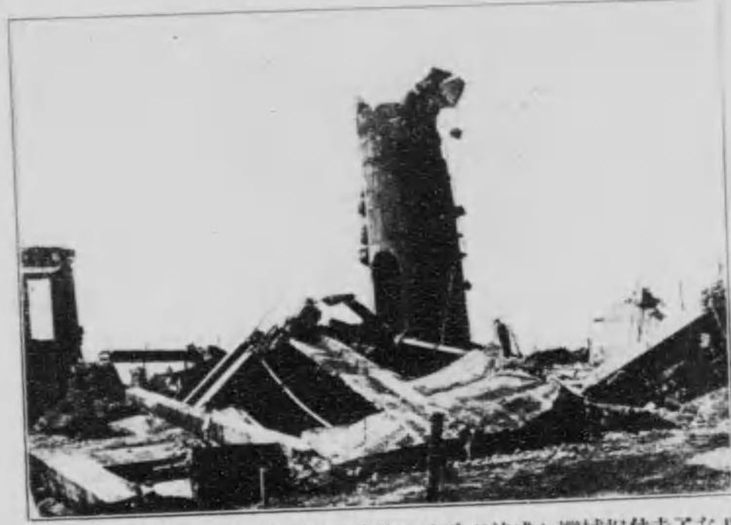
小田原電氣鐵道株式會社 平塚發電所 (建物のみ殆ど壊成し機械据付未了なりしもの)
