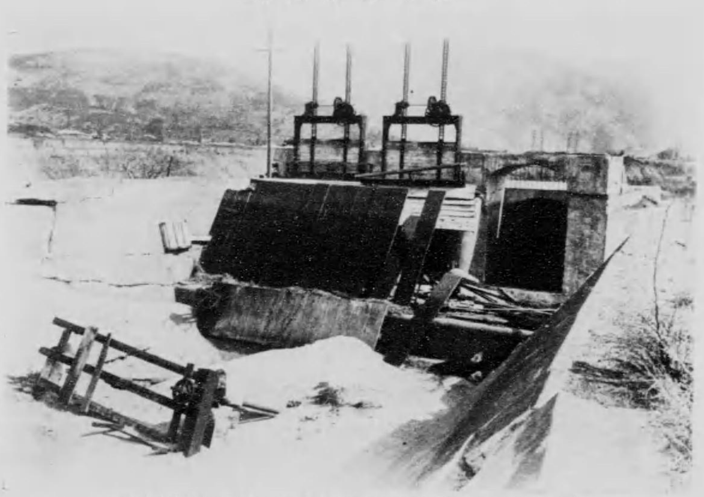
富士瓦斯紡績株式會社 内山水力水槽溢管口前側壁龜裂及び砂吐門倒壊
