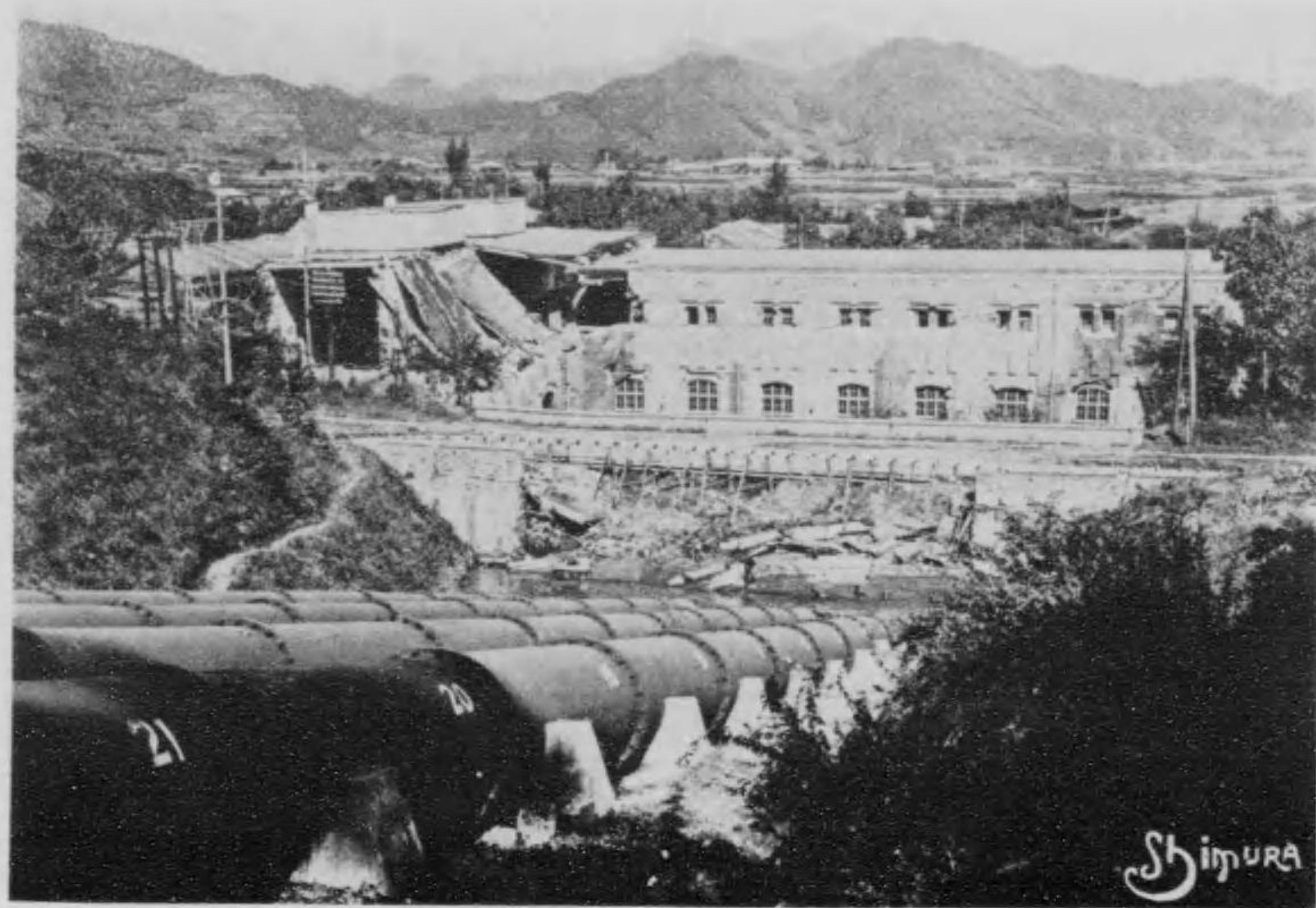
東京電燈株式會社 鹿留發電所震害狀況
