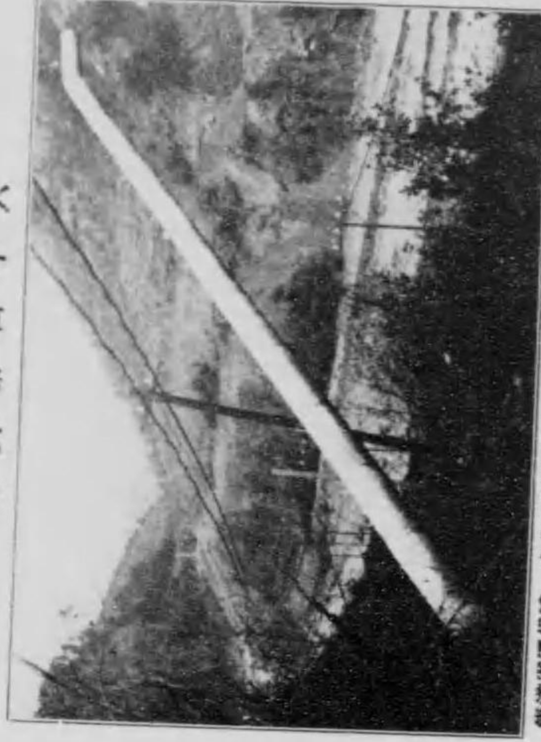
鐵道省通信線 山北谷浅間に於ける鐵筋混凝土柱の被害 (第 56 號柱)
