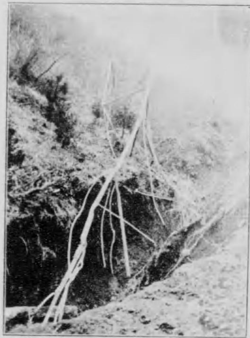
東京電燈株式会社 (峯線) 山崩れのため倒壊せる鐵塔
