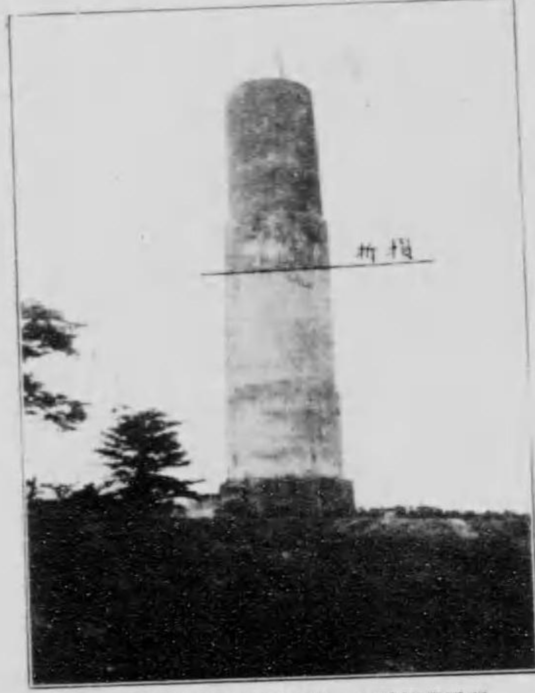
小田原電氣鐵道株式會社 三枚橋發電所 (クーラータンク 上半部黒きは崩壊せし部分を修繕したるもの)
