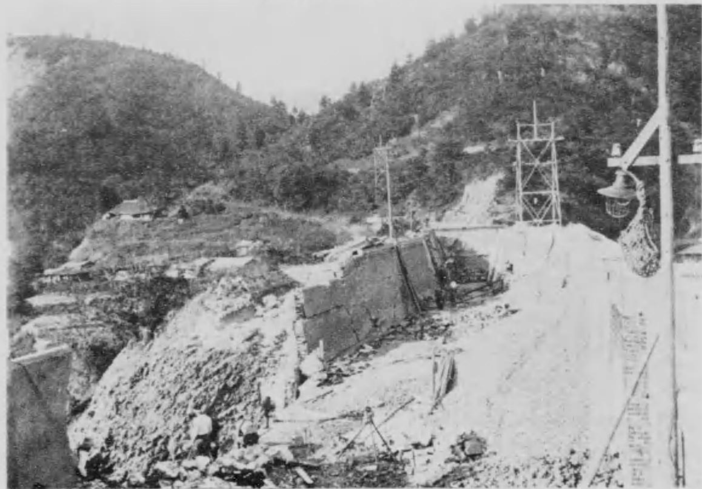
富士瓦斯紡績株式會社 山北水力水槽溢水路附近岩盤地入りと共に崩落
