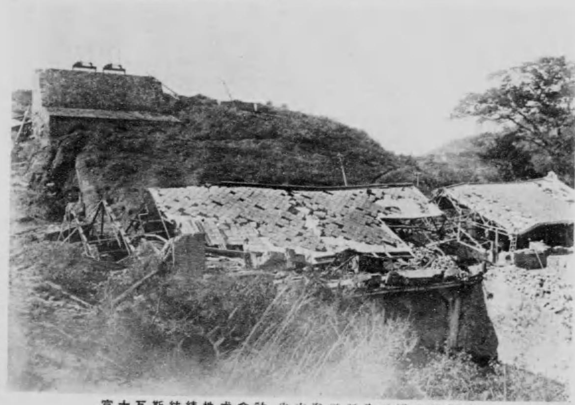
富士瓦斯紡績株式会社 内山發電所及び變電所倒壊
