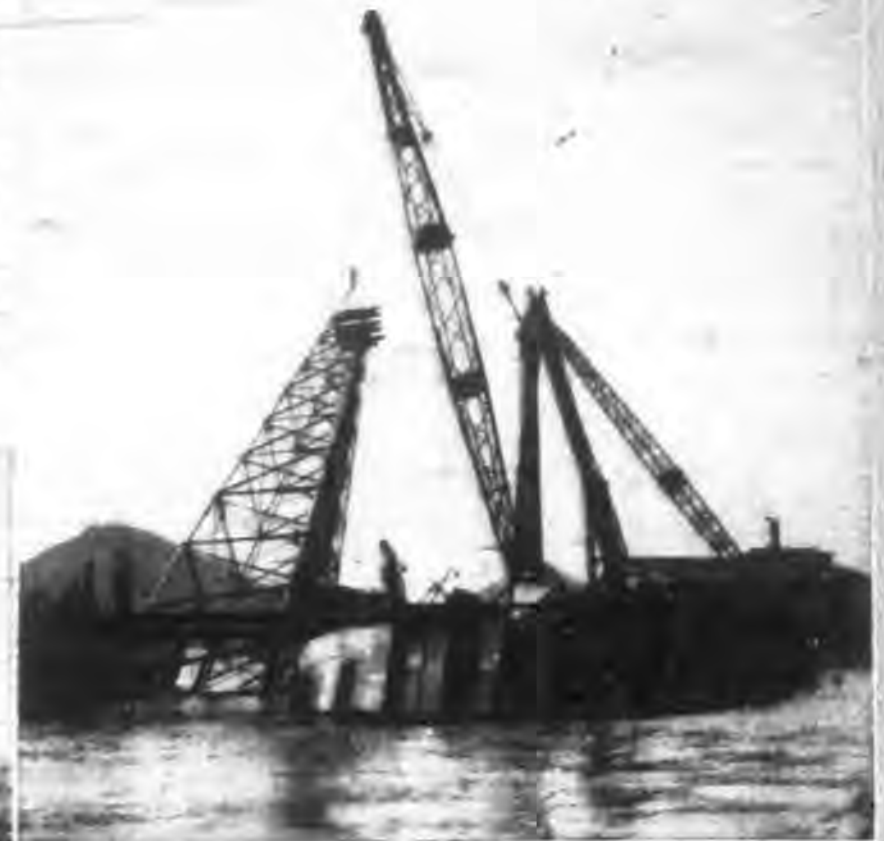
(上)漢口加築江邊堤防中聯社攝 錢江大橋之打樁機及橋墩 鋼板格被大水沖毀情形 王敦攝
