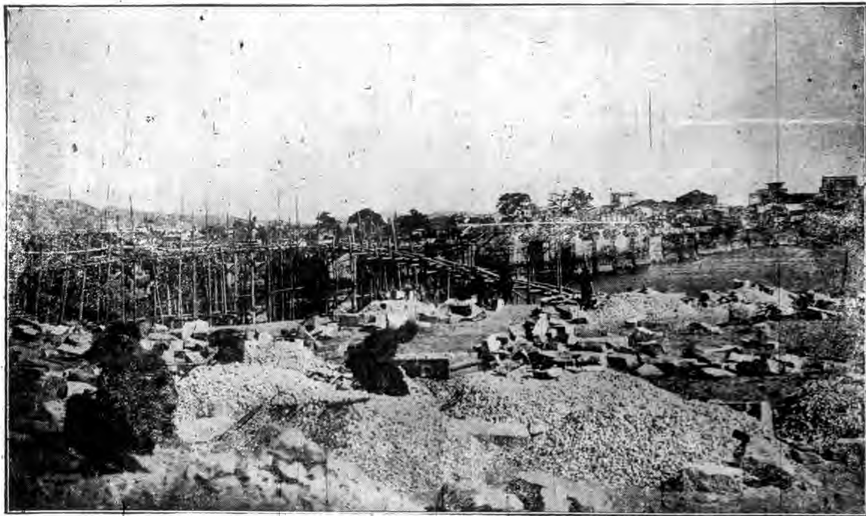
二之影撮作工橋桁土凝混筋鉄灰洋建改橋新州泉
