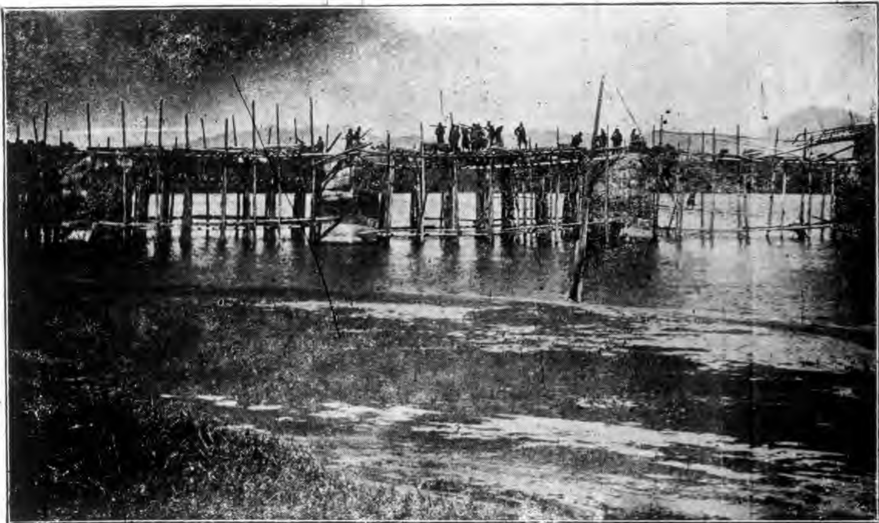
泉州新橋改建洋灰鐵筋混凝土桁橋工作攝影之四
