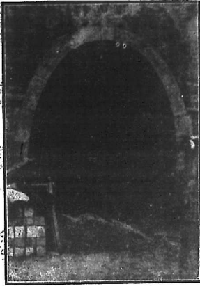
(46) 第十六號隧道西 口砌石初成之圖
