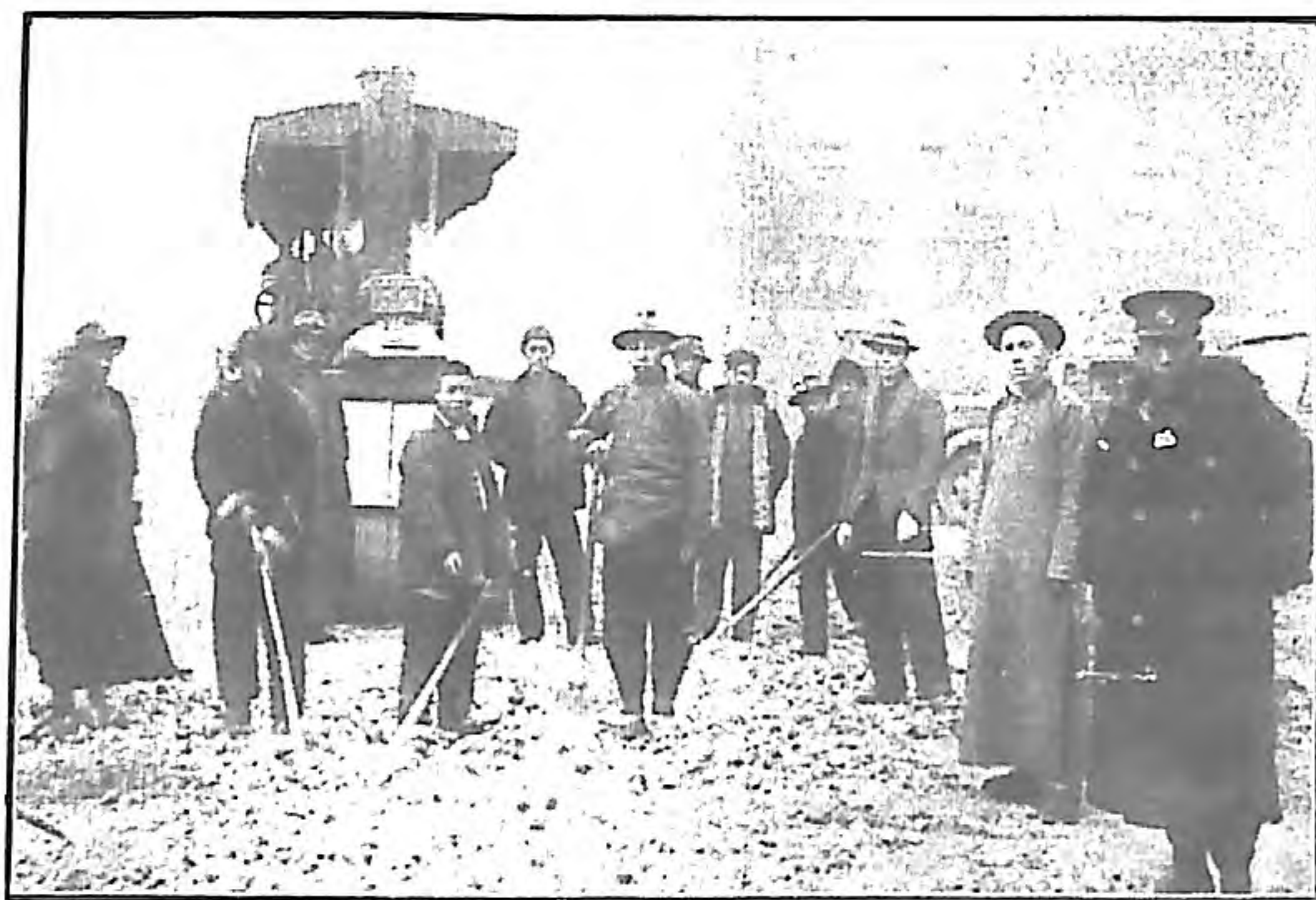
金湯橋北河沿馬路翻修碎石路面工作時情形
