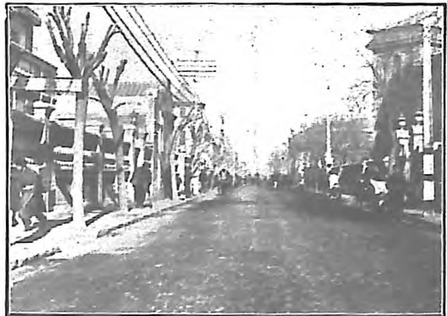
大安街修築大磗石基磗石路工竣時情形
