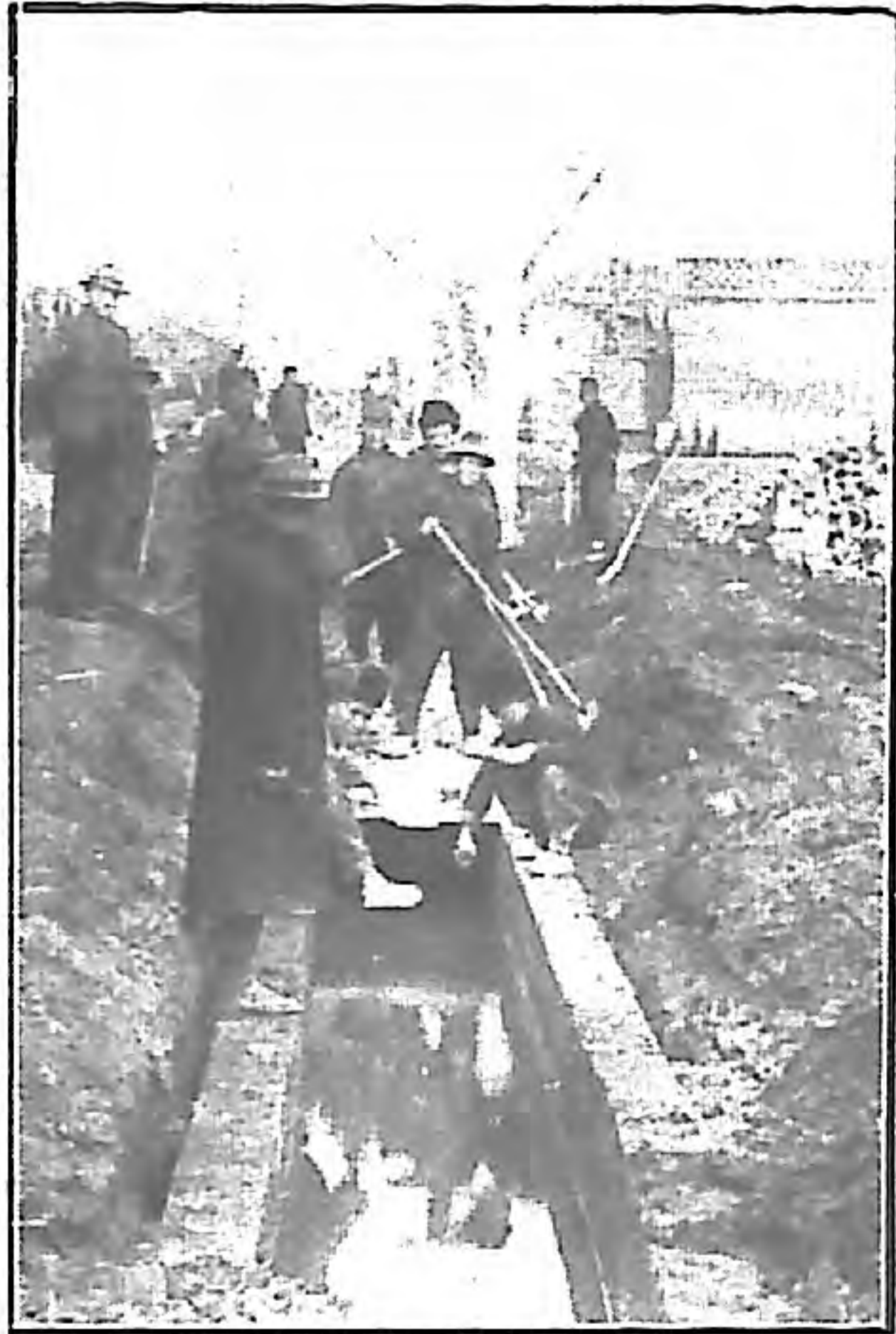
新大路修築磚幫洋灰蓋暗溝 工作情形
