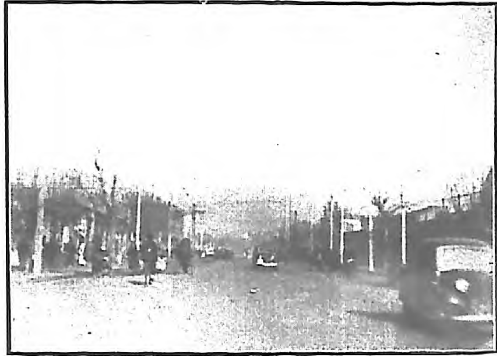
河北大經路修潑油路工竣情形
