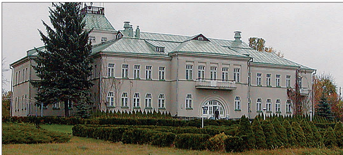
Науково-адміністративний корпус Інституту помології ім. Л. П. Симиренка Національної академії аграрних наук України, збудований професором В. Л. Симиренком наприкінці 20-х років минулого століття
