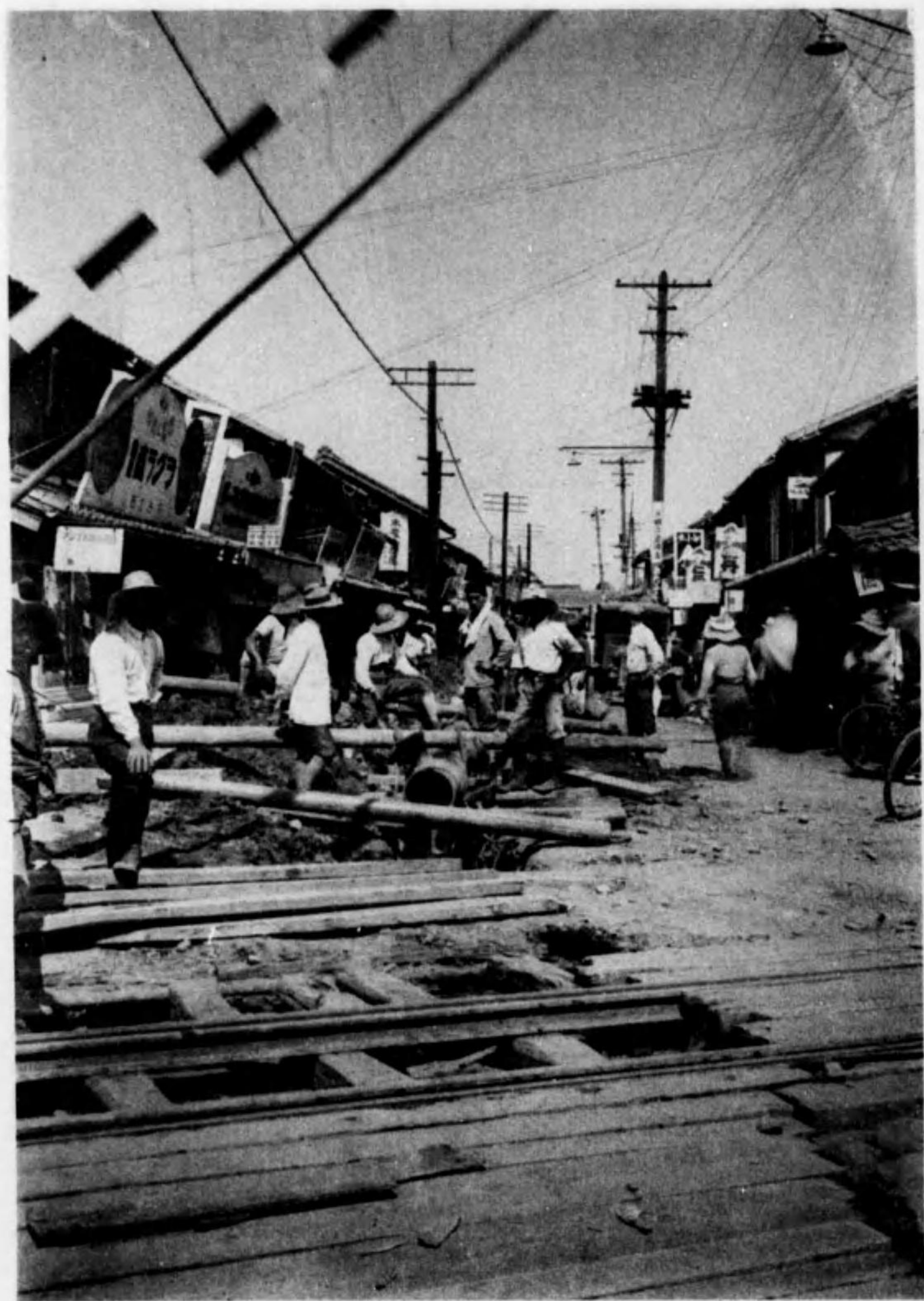
配水管施設工事之實況
