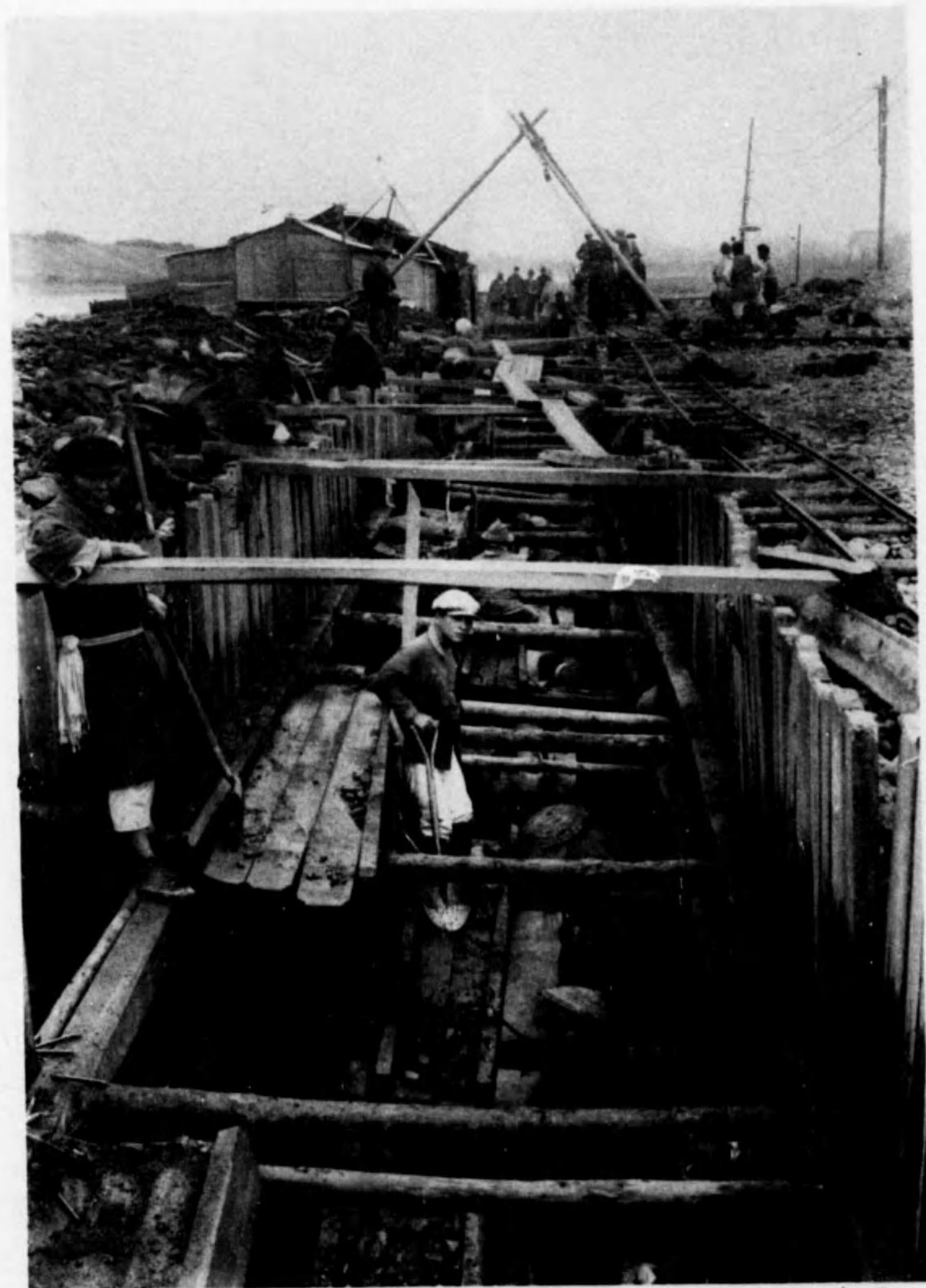
集水管埋設工事之實況
