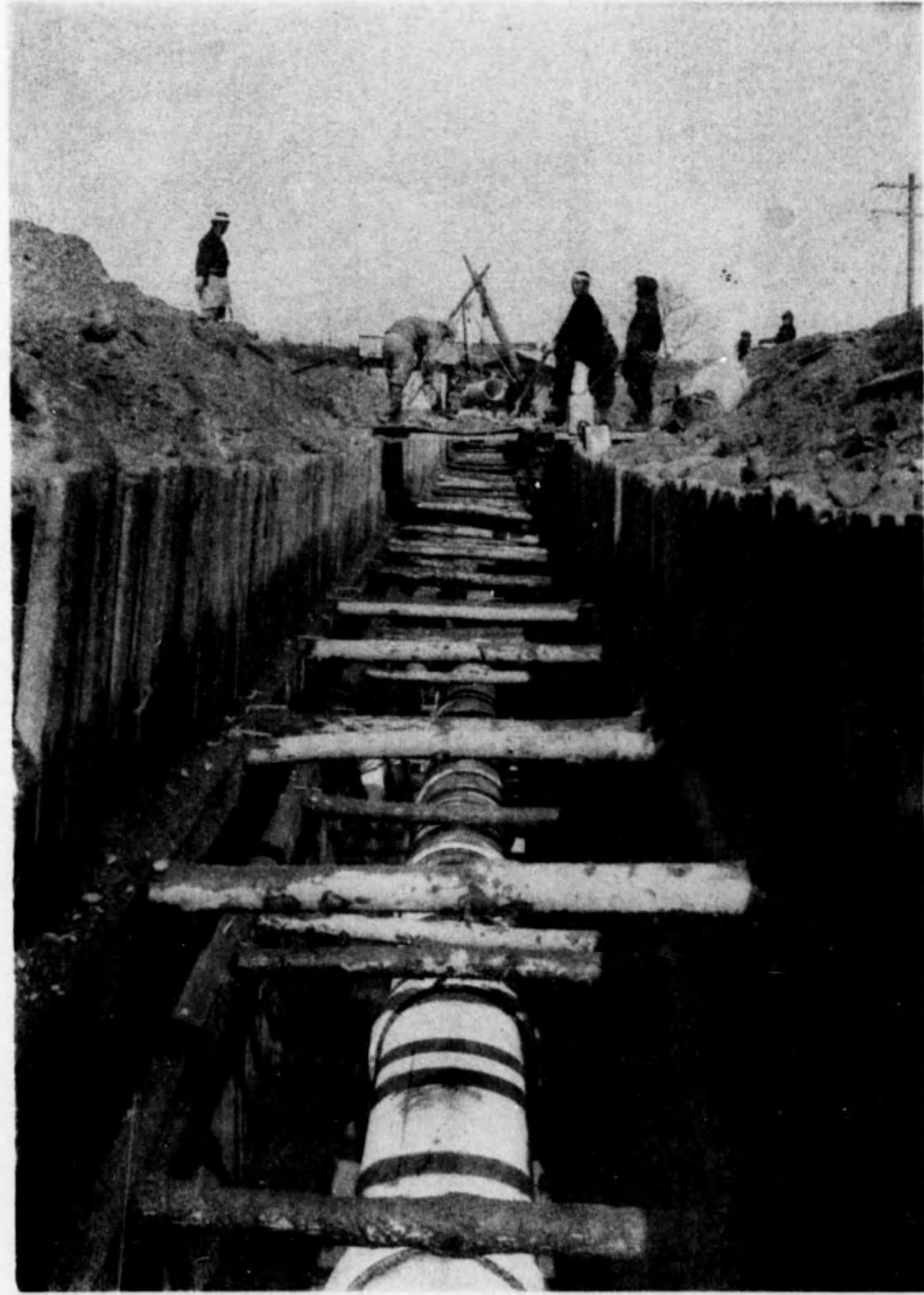
導水管埋設工事之實況
