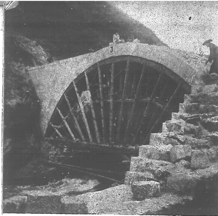
。尺公八十長，橋拱式孔乙係，橋河珥
