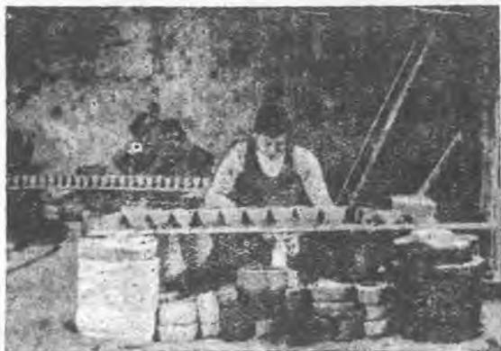
圖五十五：在陶車上製坯
