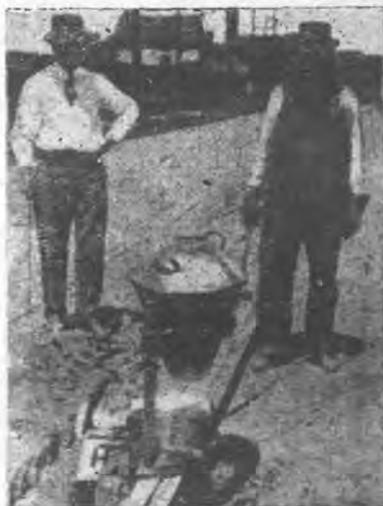
圖五十四：用鋁鎔接劑焊接鐵軌
