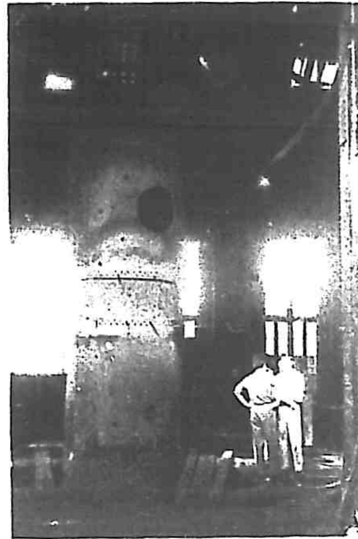
一三〇噸水壓鉚釘機前 吊起之鍋爐
